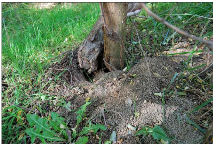
Abbildung 19: Nagetierschaden in einer KU-Anlage in Groß Enzersdorf; Quelle: Deim 2010
