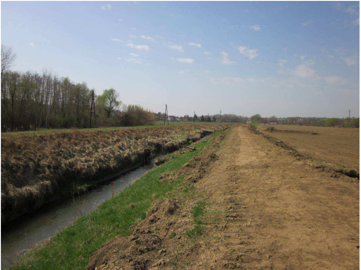
Abb. 39: alter Zayadamm mit bereits abgetragener Grasnarbe auf der Dammkrone (Zaya, April 2012)
