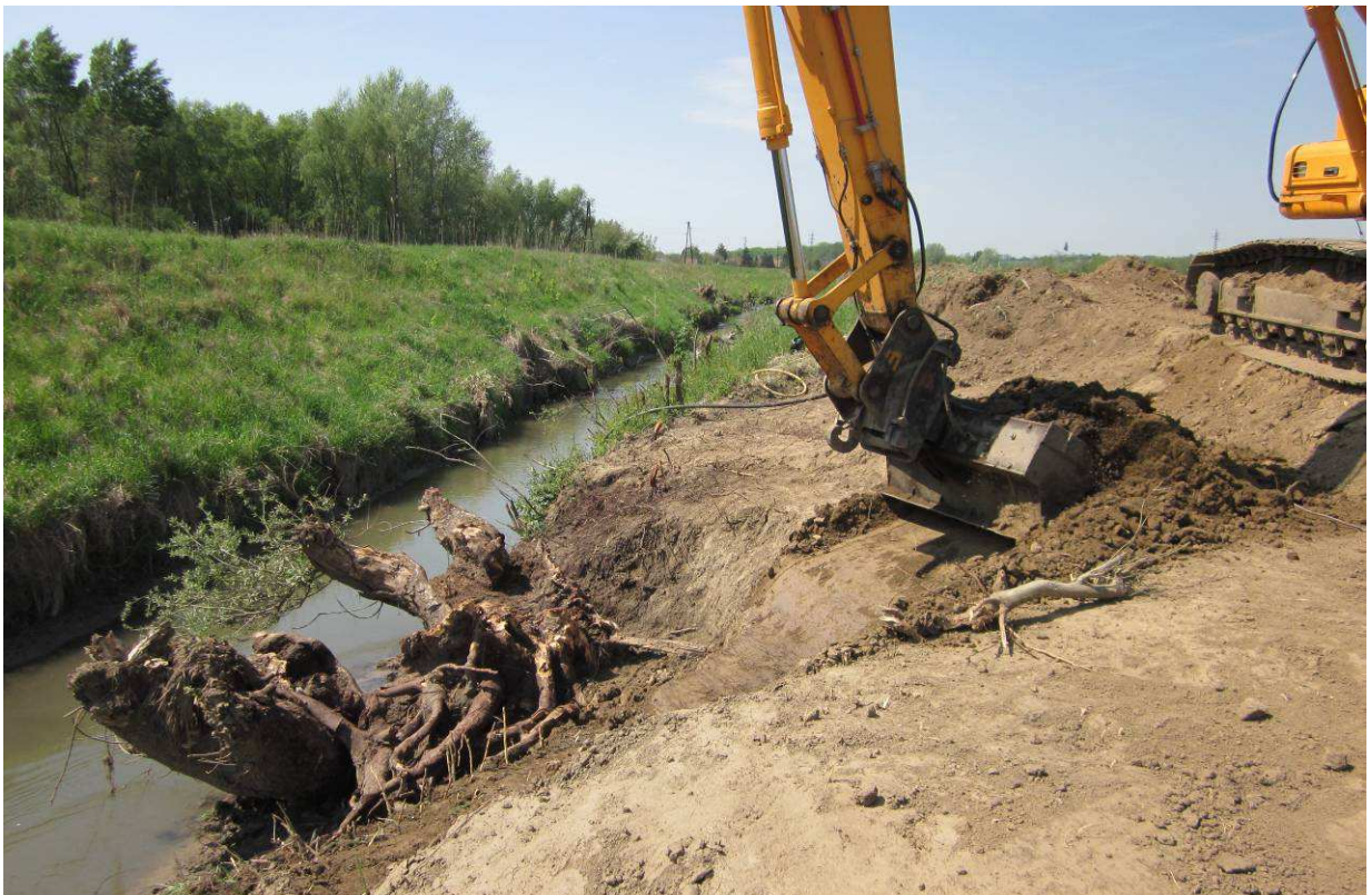
Abb.40: Freischaufeln des Wurzelstocks mit Hilfe des Baggers (Zaya, April 2012)
