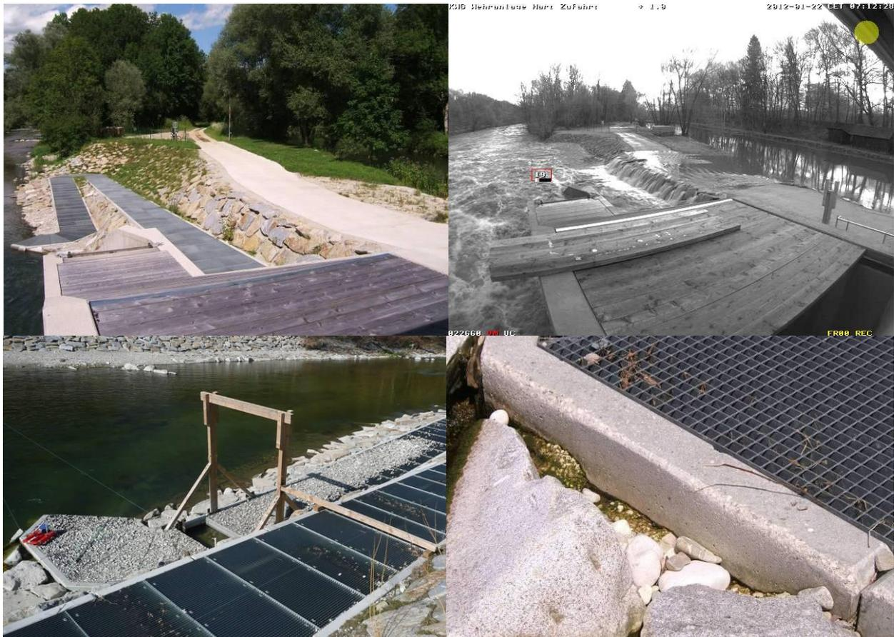
**Abb. 5-26 oben: Hochwasserentlastung über Zufahrtsstraße am 22.01.2012 bei Spitzenabfluss von 241 m<sup>3</sup>/s (Restwasser 223 m<sup>3</sup>/s), Quelle: KWG; unten links: Steinteppich auf Gitterroste der FMH, 17.03.2012; unten rechts: Erosierte Betonkante am Fertigteil des Einstieges der FMH, 18.07.2012**
