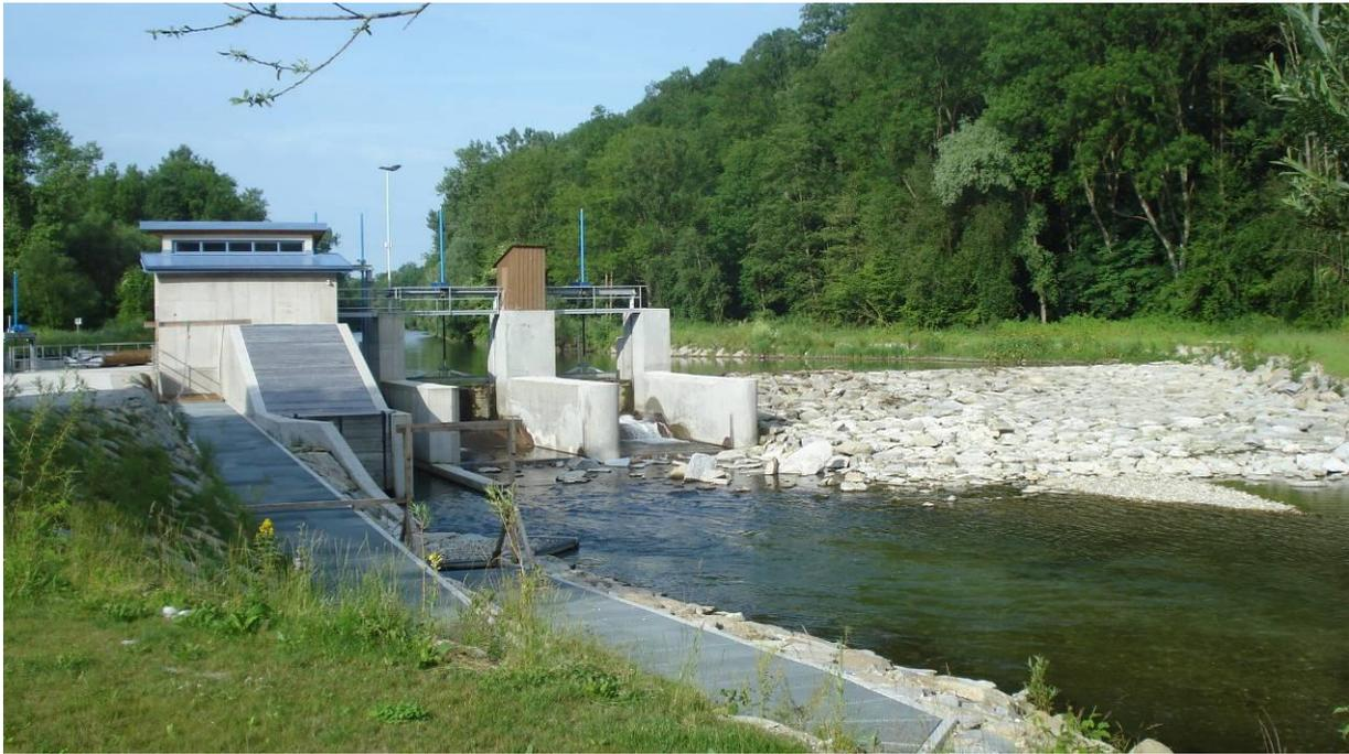
**Abb. 3-25: KW Hart mit Wehranlage, enature® Fishpass und Blocksteinrampe. Blickrichtung flussauf. 2012.**
