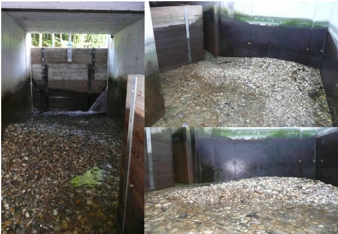
Abb. 5-25 ; links: Geschiebeablagerung im Vorlaufbecken und Leckagen am Schütz, 04.07.2012; rechts: Geschiebeablagerung von ca. 1m<sup>3</sup> unterhalb von Schlitz 19 (Reusenbecken 1) während der Frühjahrsperiode, 04.07.2012
