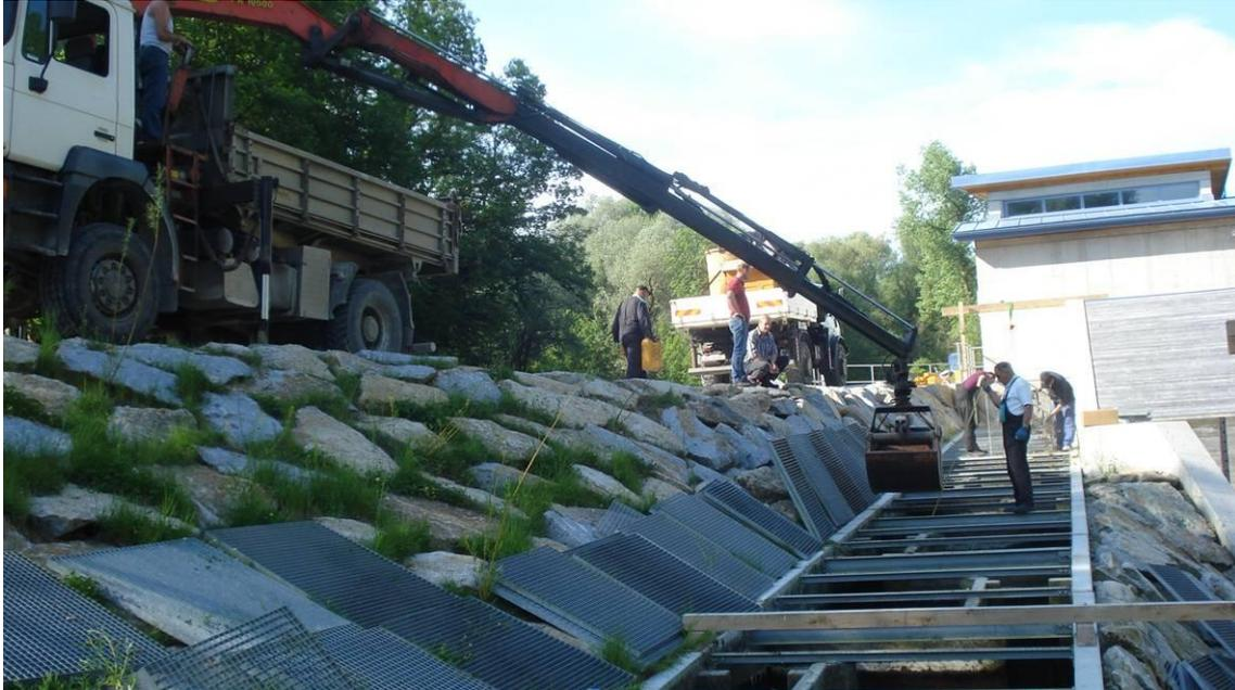
**Abb. 4-15: Sohlsanierung der FMH am 22.05.2012.**
