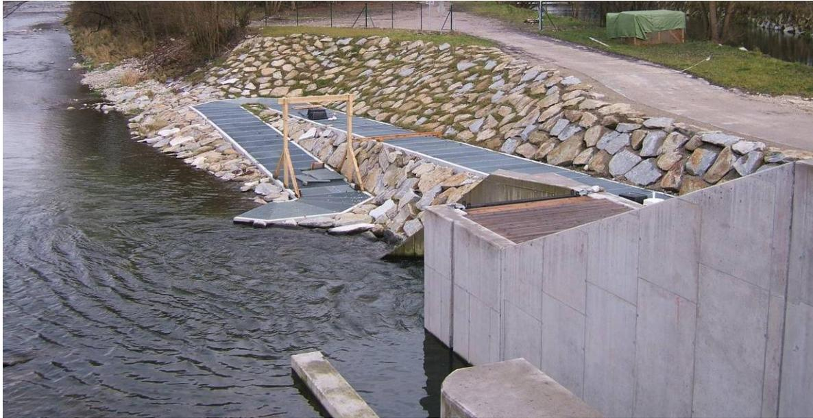
**Abb. 3-31: Rechtes Agerufer (Ausleitungsstrecke) mit enature® Fishpass Einstiegsbereich, 180° Kurve und montierten Galgen für die Reuse 2. Rechts unten Turbinenauslass und Einhausung der Wasserkraftschnecke. Rechts oben Werkskanal in Blickrichtung KW Glatzing/Rüstorf. 2012.**
