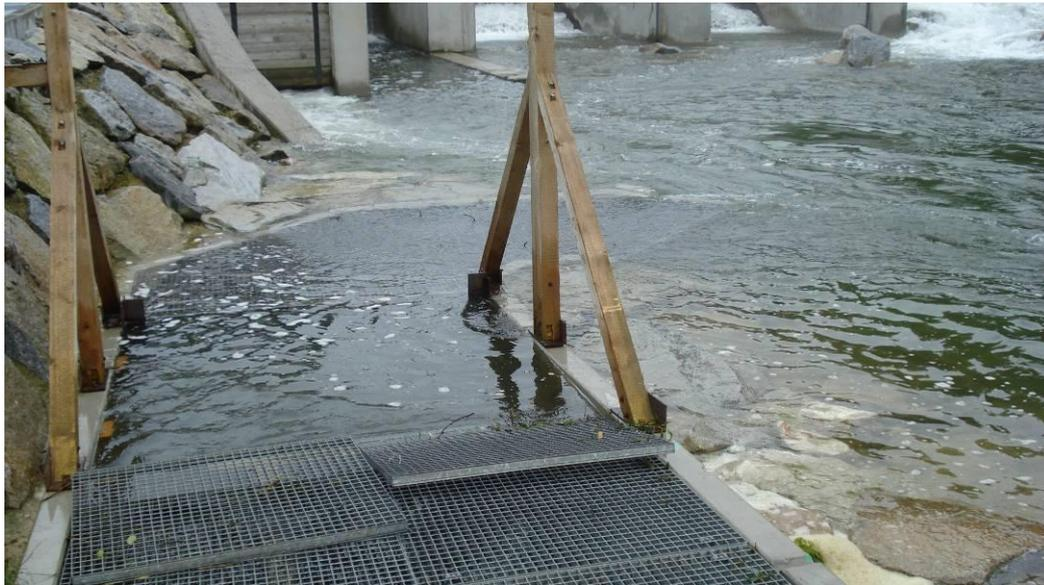
Abb. 5-5 Überströmter und eingestauter Einstieg der FMH, 06.06.2012, WSP-UW 359,43 m.ü.A., Q-Rest ca. 12,8 m<sup>3</sup>/s
