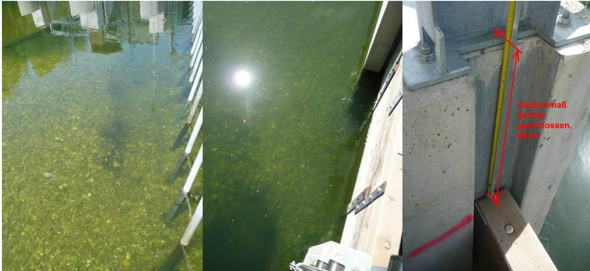
Abb. 5-24 links: Mit Schotter bedeckte Kragchwelle, 01.05.2012; mittig: Geschiebebezug in Kanal zum Einlauf der FMH, 01.05.2012; rechts: Vollständig abgesenktes Schütz mit OK 362,6 m.ü.A.
