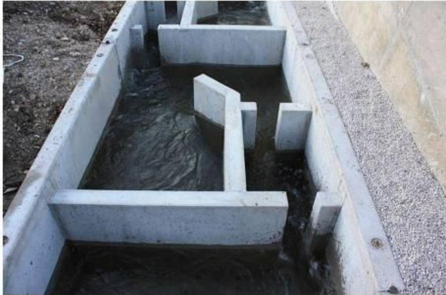
**Abb. 3-26: Anordnung der Strukturelemente in einem Fertigteilelement des enature® Fischpasses.
