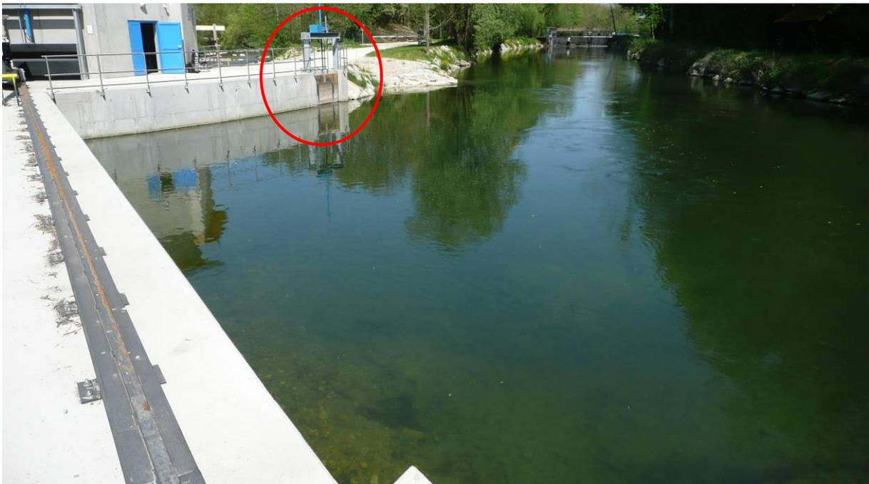
**Abb. 3-32: Einlaufsteg zum Werkskanal (links) sowie Schütz mit FMH – Ausstieg (rot eingekreist). Blick in Fließrichtung. 2012.**
