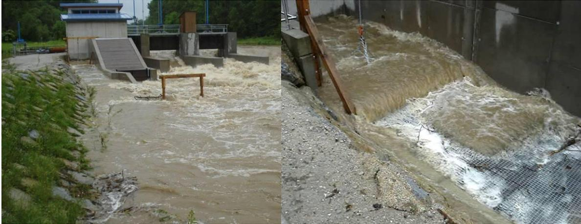
**Abb. 5-27 Hochwasser (ca.  $HQ_1$ ) am 13.06.2012; links: eingestautes UW an FMH; rechts: Überströmte Reuse 1**
