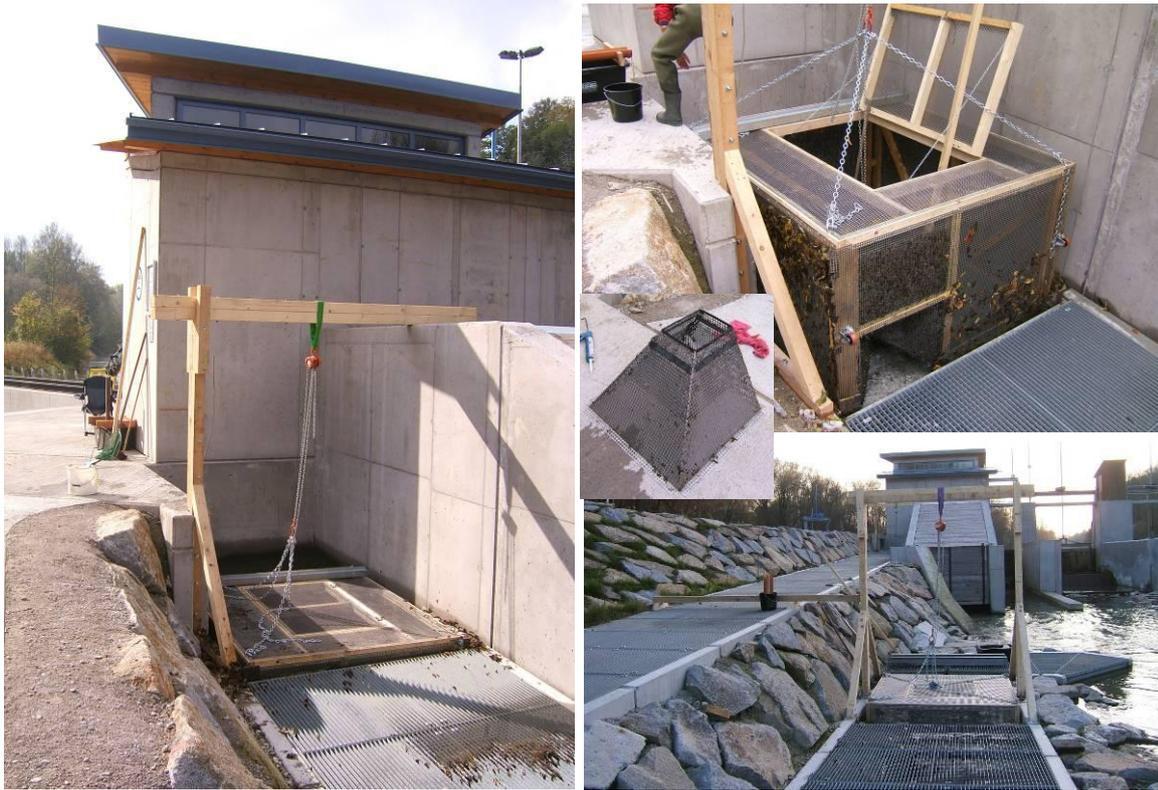
**Abb. 4-18 Bilder der Reusen: Ausstiegsreuse (Reuse 1) links; Reuse 1 mit Kettengegenzug hochgezogen (Bild rechts oben); Einstiegsreuse (Reuse 2) rechts unten; ausgebauter Einstiegstrichter Bild Mitte rechts**
