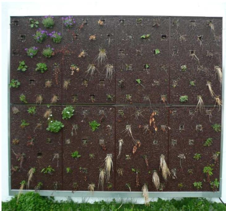
Abbildung 37: modulares Begrünungssystem mit Pflanzkörben im Versuchsgarten Wien Essling 2011 (Foto: IBLB).
