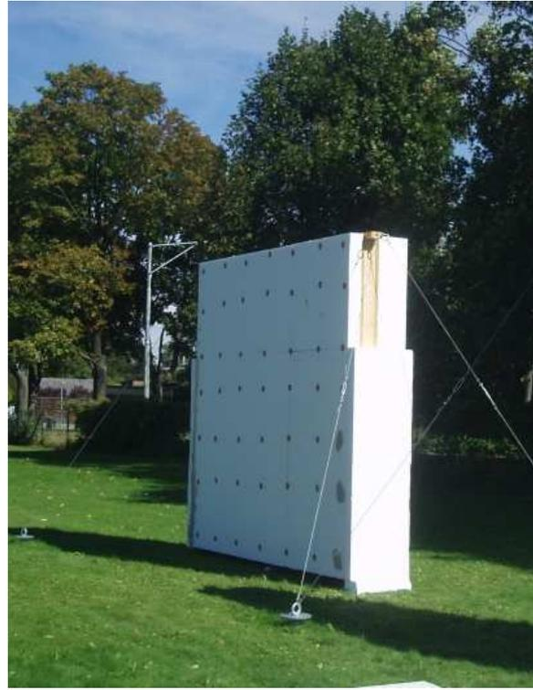
Abbildung 54: Aufbau der Putzfassade; im Kern ist die Holzriegelwand sichtbar, darauf wurden Fassadendämmplatten befestigt (Foto: IBLB 2010).
