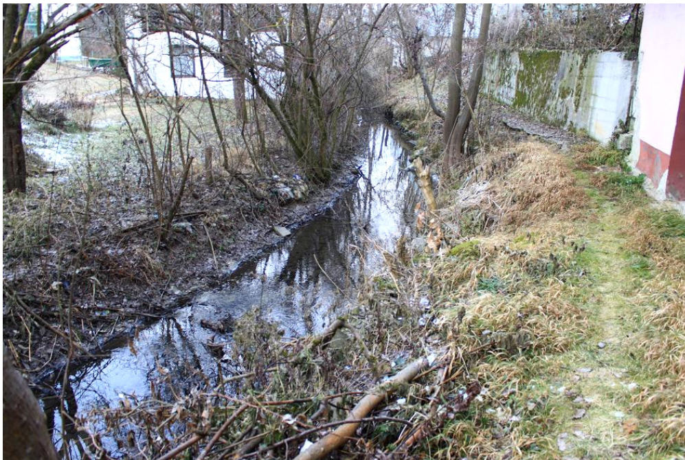
Abbildung 5-13: Durch HQ 30 bedrohtes Wohnhaus (links) vor Querprofil 55
