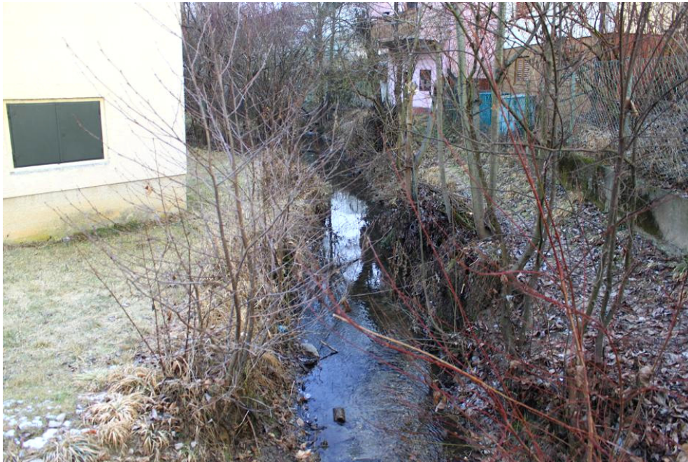
Abbildung 5-12: Trafostation im HQ 30 Gefährdungsbereich bei Querprofil 57
