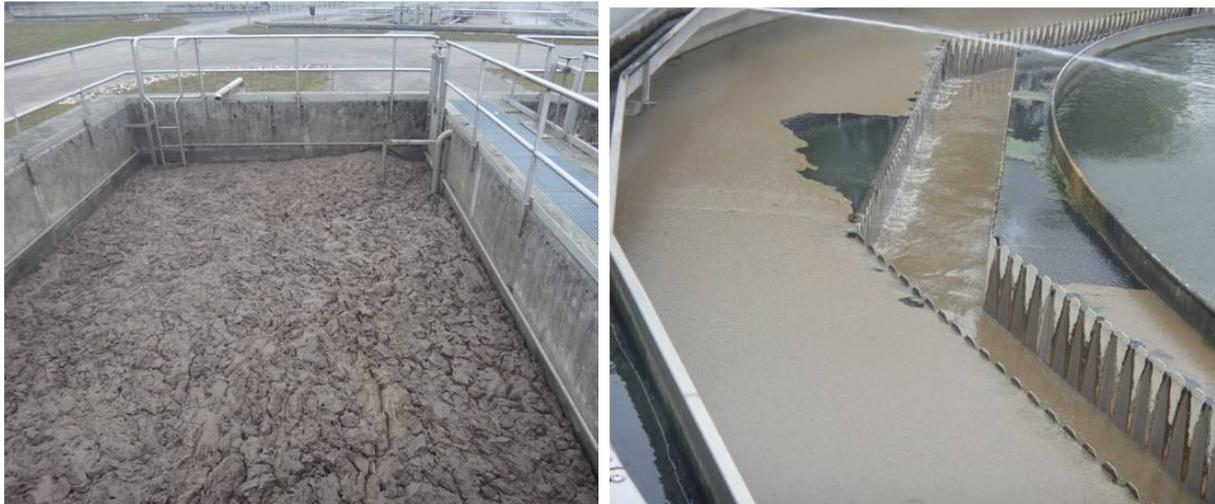
Abbildung 1: Schwimmschlamm im Belebungsbecken und Nachklärbecken
