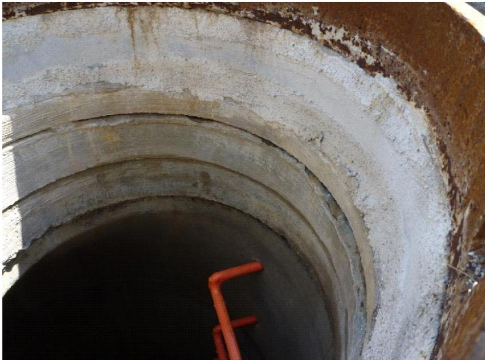
Abbildung 163: Oberflächenschäden bei den Auflageringen
