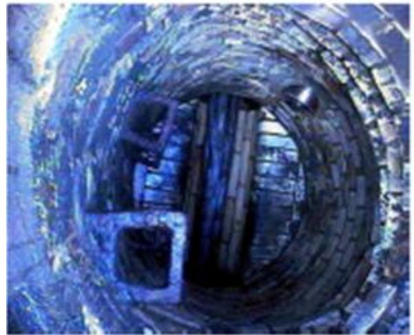
Abbildung 59: gemauerter Schacht, rund (Bölke, 2013)
