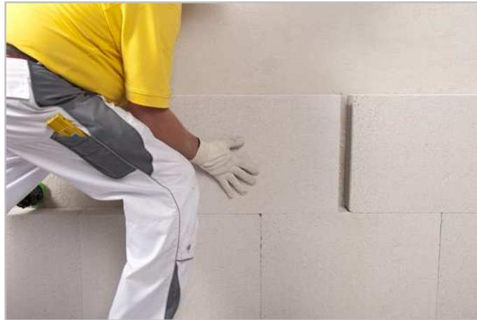
Abbildung 24: Multipor Dämmplatten (Xella Porenbeton Österreich GmbH, o.J.)
