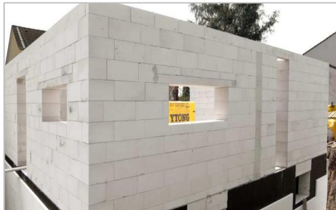
Abbildung 20: Bauweise Porenbeton: Ytong Stein (Xella Porenbeton Österreich GmbH, o.J.)
