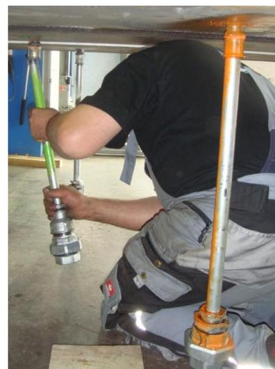
**Abb.:18** Foto - Entwässerung inkl. Rückschlagventil (Quelle: eigene 2013)
