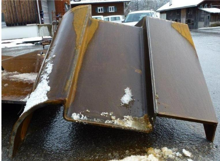
**Abb.:3** Foto - Querschnitt der verlorenen Schalung (Quelle: WLV 2013)
