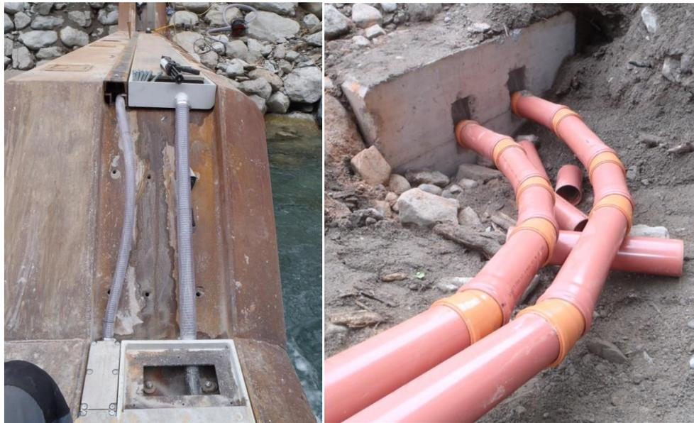
**Abb.:4** Fotos - Kabelführung. Links: Schutzrohr unter Abdeckung im Bachbett; Rechts: Leerrohre aus dem Sperrenflügel, mit ausreichendem Kurvenradius (min.  $r > 2,5$  m), welcher das Einziehen der Kabel ermöglicht (Quelle: eigene 2013)
