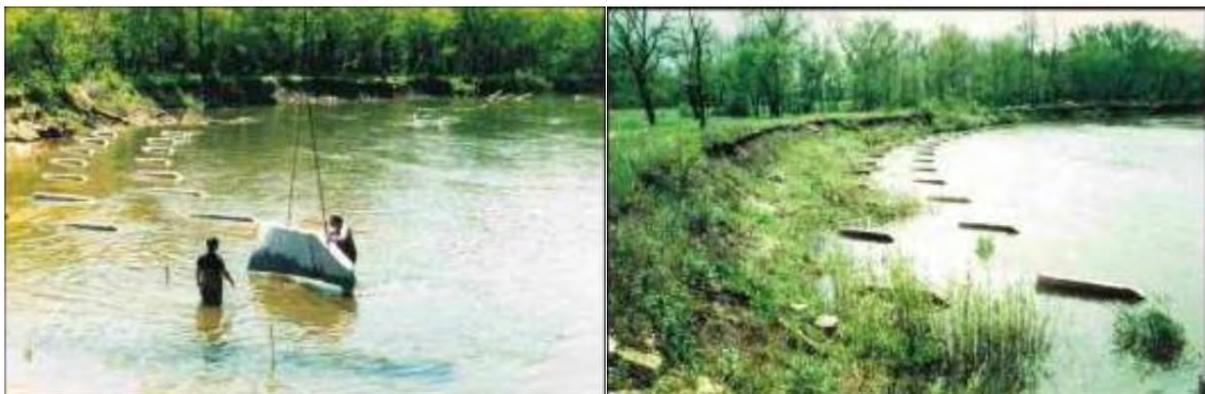
Abbildung 3-4: Einbau von Iowa Vanes in den Wapsipinicon River bei Niedrigwasser im Sommer 1988 (links), Ufer des gleichen Flussabschnitts des Wapsipinicon River 2 Jahre nach Einbau bei Niedrigwasser 1990 (rechts); (MENDE, 2005; aus ODGAARD, 2005)
