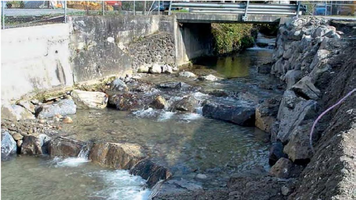
Abbildung 7-46: Blocksteinriegel als Rauheitselemente zur Verringerung der Fließgeschwindigkeit im Zulaufbereich zur Pendelrampe inklusive linksufriger Verbreiterung (MENDE, et al., 2009)
