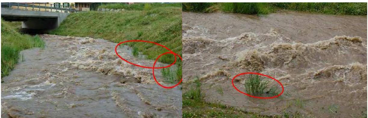
Abbildung 7-16: Strömungsberuhigung am Prallufer (Basler & Hofmann West AG, 2013)
