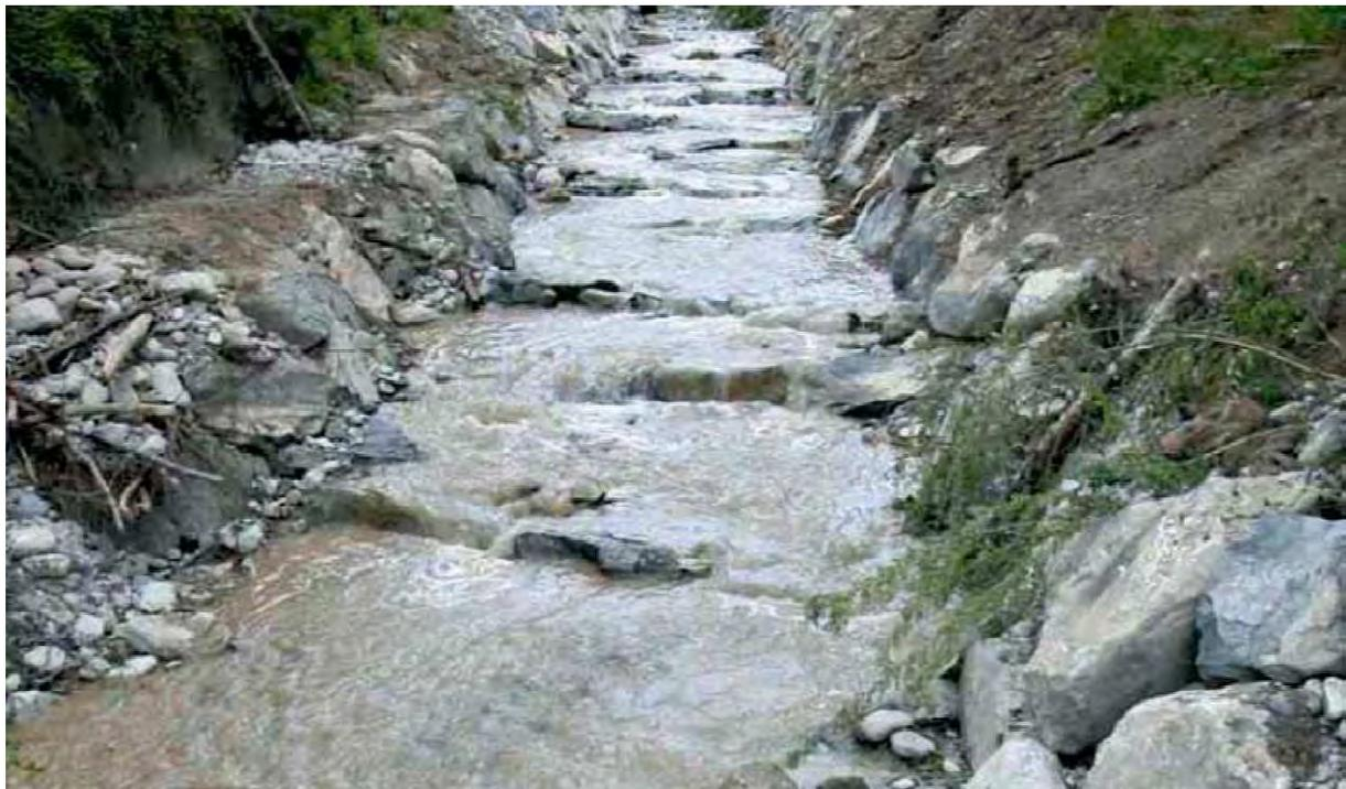
Abbildung 7-43: Erstaufführung der Pendelrampe unmittelbar nach Fertigstellung im Mai 2007 (MENDE, et al., 2009)
