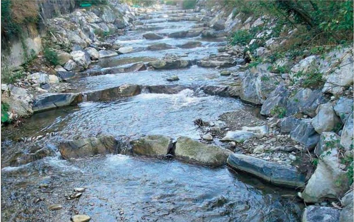
Abbildung 7-44: Optimierte neue Pendelrampe mit bogenförmigen, in der Böschung verankerten Riegeln im September 2009 (MENDE, et al., 2009)
