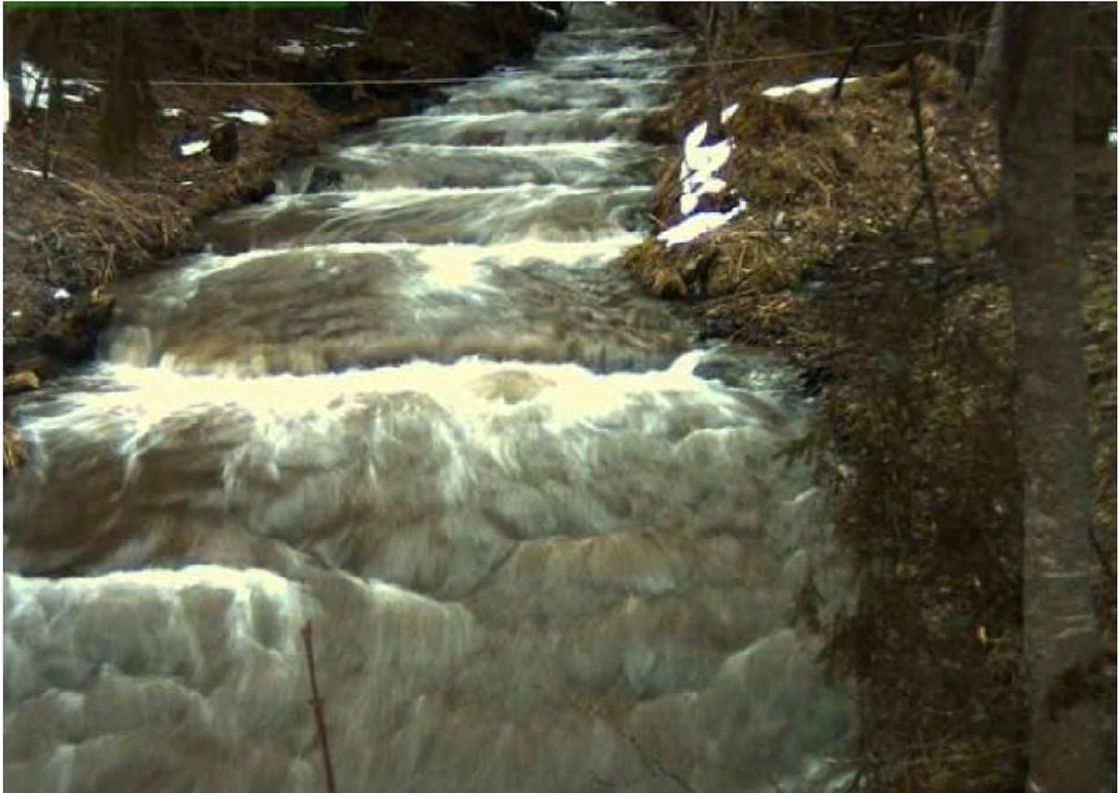
Abbildung 7-41: Pendelrampe bei Schmelzwasserabfluss im März 2010 (MENDE, et al., 2010)
