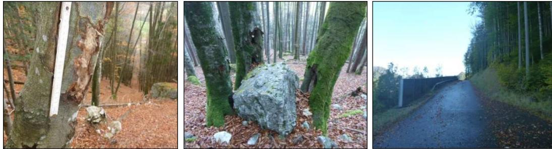
Abbildung 29: Dokumentation von Einschlagmarken, und Sturzblöcken, sowie vorhandene Holzschlachtenwände (MÜLLER 2013).
