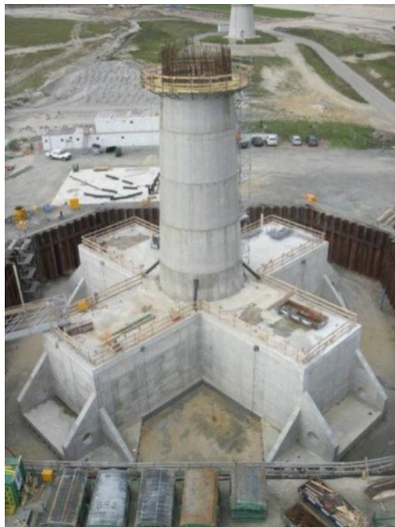
Abbildung 13: Luftbildaufnahme des Testfundaments während der Bauphase
