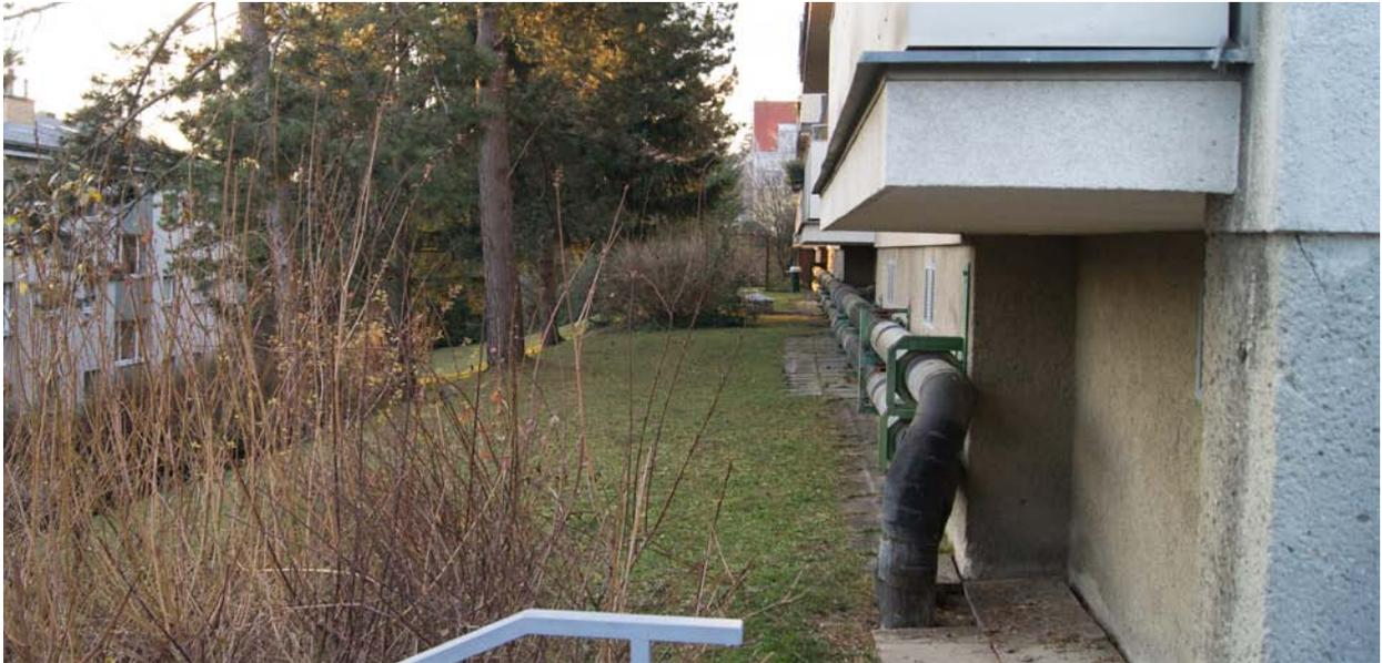
Abb. 62 Freiliegende Wärmeleitungen [Quelle: eigene Abbildung]
