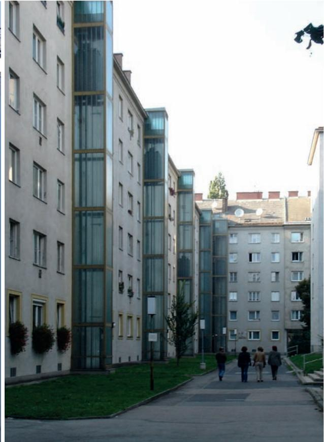
Abb. 46 Hofansicht der Wohnhausanlage Kapaunplatz 7 mit neuen thermisch getrennten Balkonen und Dachgeschoßausbauten (links) [78]
