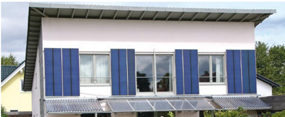
Abb. 75 Verschiebbares Verschattungselement mit PV-Modulen [99]
