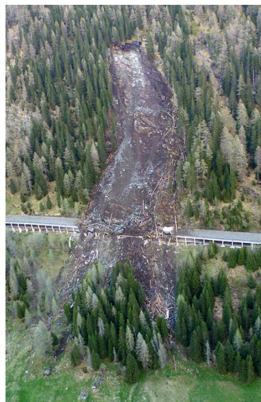
Fig. 2: Landslide at Felbertauern - 2013 (TOURENFAHRER)
