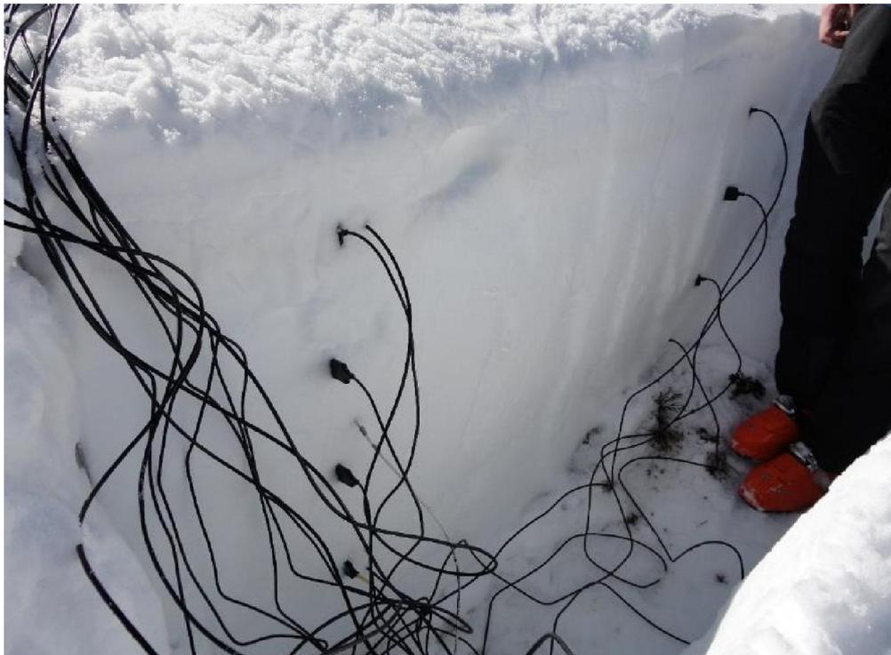
Abbildung 2-2: Eingebaute Sensoren der permanenten Wassergehalts- und Temperaturmessung vor Wiederverfüllung des ausgegrabenen Schachts (Foto: Martin Forster, 2014)
