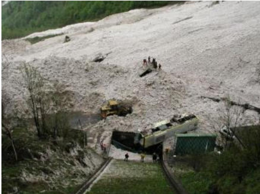
Abbildung 1-1: Ablagerung der Griesbachlawine (Kaprunertal) vom 22. Mai 2004, im Bild der verschüttete Vorbereich der Talstation des Lärchwand-Schrägaufzuges und der erfasste Linienbus (Foto: VERBUND-Austrian Hydro Power AG, Werksgruppe Kaprun-Salzach)
