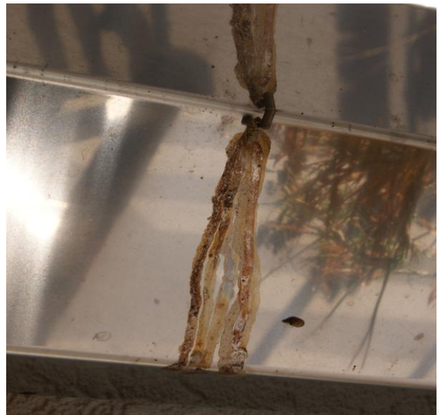
Abbildung 6: Beginnende Korrosion (selbsterstellt)
