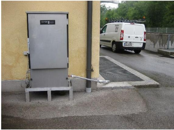
Abbildung 20 Zulaufmessstelle: links: gekühlter Probenschrank, rechts: Probenahme- u. Messstrecke
