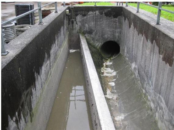
Abbildung 18 Zulaufdrossel mit Überlauf zum Regenüberlaufbecken
