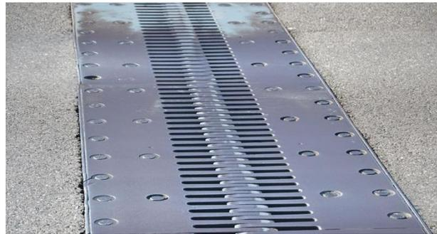
Abbildung 125 Kragfingerkonstruktion mit zweiter Schraubenreihe
