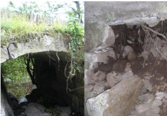
Abbildung 3.47: Bei hm ~24,67 (7), Beschädigung der Brücke am Güterweg, Brückenhöhe 16 m, Aufnahme datum 18.09.2014.
