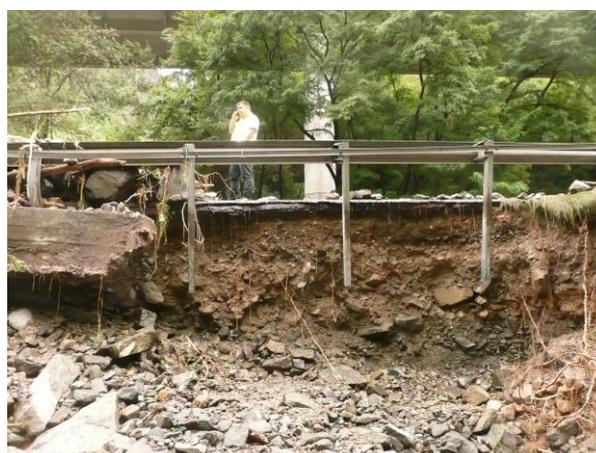
Abbildung 3.53: Bei hm ~0,35 (30), kaputte Leitplanken und deren Fundament links der Unterquerung, Aufnahmedatum 01.09.2014 (Philipp Walder).
