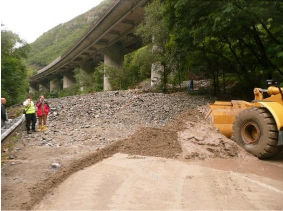
Abbildung 3.35: Beginn der Aufräumarbeiten, bei hm ~0,59 (29), murartige Ablagerung auf SS12, in Fahrtrichtung Bozen, Aufnahmezeitpunkt 01.09.2014 um 08:12 MEZ (Philipp Walder).
