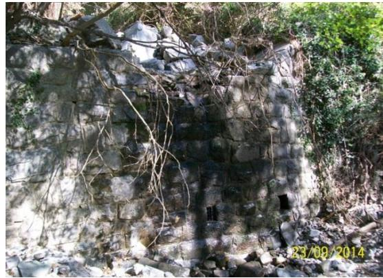
Abbildung 3.48: Bei hm ~4,36 (23), beschädigte Sperre (Projektnr. 59019), einzelne Kronensteine fehlen, Aufnahme datum 23.09.2014 (Georg Kompatscher).
