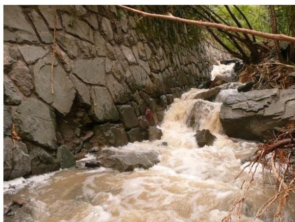
Abbildung 3.52: Bei hm ~1,38 (28), kleiner Schaden der Ufermauer- Großteiles jedoch sehr guter Zustand, Aufnahmedatum 01.09.2014 (Philipp Walder).
