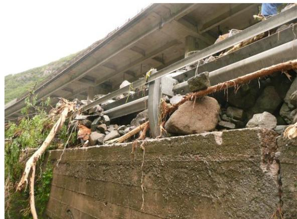
Abbildung 3.23: Murartige Ablagerung, breite und unsortierte Kornverteilung, bei hm ~0,55 (30), Aufnahme- datum 01.09.2014 (Philipp Walder).
