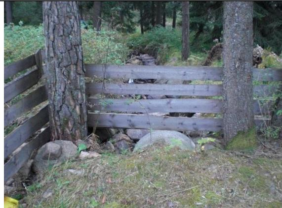
(2) hm ~30,54; Ende der Verrohrung des Gastererbaches, kommend aus der Handwerkerzone, Rohrdurchmesser 80 cm, Steinkünette reichte für den Hochwasserabfluss gerade noch aus. Aufnahmedatum rechts 18.09.2014, Aufnahmedatum links 04.09.2014 (Georg Kompatscher)
