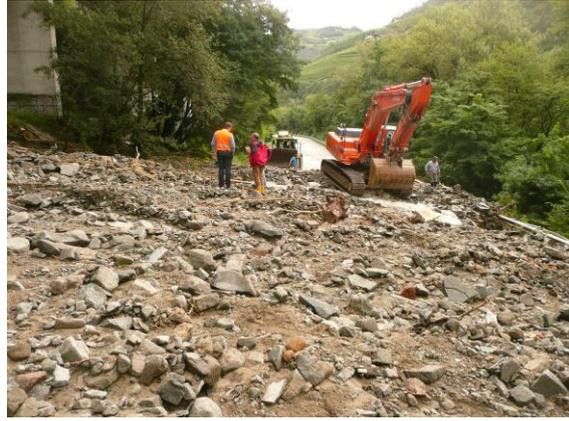
Abbildung 3.36: Beginn der Aufräumarbeiten, bei hm ~0,59 (29), murartige Ablagerung auf SS 12, in Fahrtrichtung Brenner, Aufnahmezeitpunkt 01.09.2014 (Philipp Walder).
