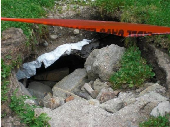
Abbildung 3.45: Bei hm ~28,82 (4), Rohrbruch: Loch in Forststraße, Aufnahme datum 18.09.2014.
