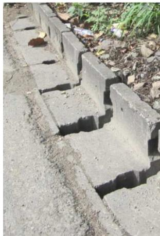
Die straßenseitige Entwässerung der Oberfläche erfolgt entlang des Prithivi Highways durch seitlich angeordnete Rinnen. Zum Einsatz kommen offene Trapezzinnen mit Steinbettung sowie abgedeckte Rechteckrinnen aus Betonfertigteilen (Abb. 4-3). Durch die Abdeckung sind die Rechteckrinnen vor Ablagerungen und Verschmutzungen
