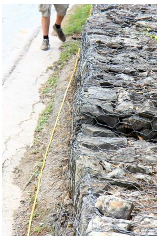
Durch die Kippbewegung entstanden zwischen Bankett und Mauer Risse und in weiterer Folge unversiegelte Flächen, wodurch Oberflächenwasser in den Erdkörper infiltrieren kann (siehe Abb. 5-23). Im Zuge der Instandhaltungsmaßnahmen sollten diese Flächen versiegelt werden. Außerdem ist die Mauer auf Grund eines Fahrzeuganpralls stark beschädigt (siehe Abb. 5-18). Die Deformation und der Ausbruch in der Mauer beeinflussen das Eigengewicht und die Lage der resultierenden Kraft negativ.
