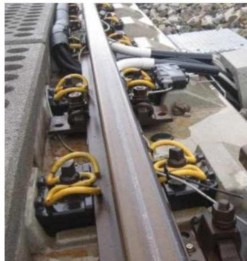
Abbildung 4: Schienenbefestigung L110 [9]
