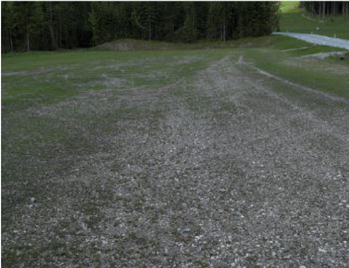
Bild 3: Zustandsbild des Parkplatzes in Gosau zwei Jahre nach der Anlage des Schotterrasens mit der stark befahrenen Fläche im Vordergrund (Quelle: Graiss und Krautzer 2013, 16)
