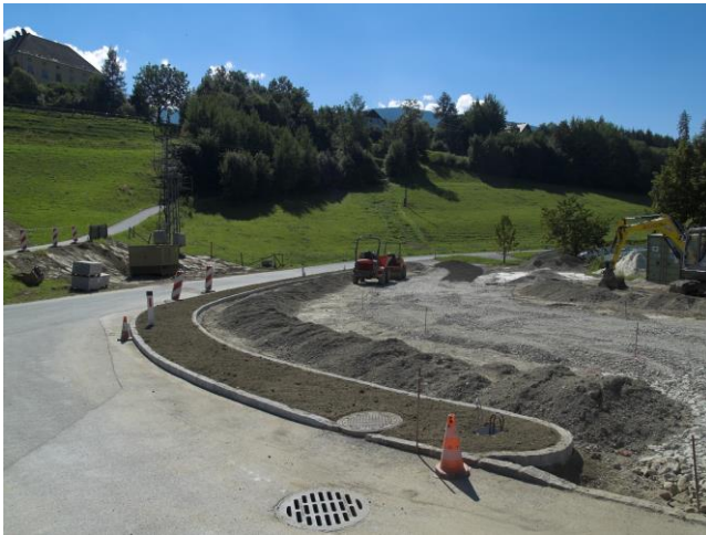
Bild 4: Aufbringen des Schotterkörpers (links) und fertiggestellten des Schotterrasens (rechts) (Quelle: Graiss 2013)
