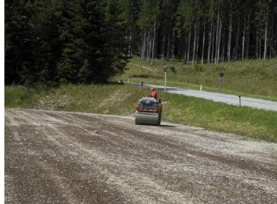
Bild 2: Walzen der eingesäten Fläche (Quelle: Graiss und Krautzer 2013, 15)
