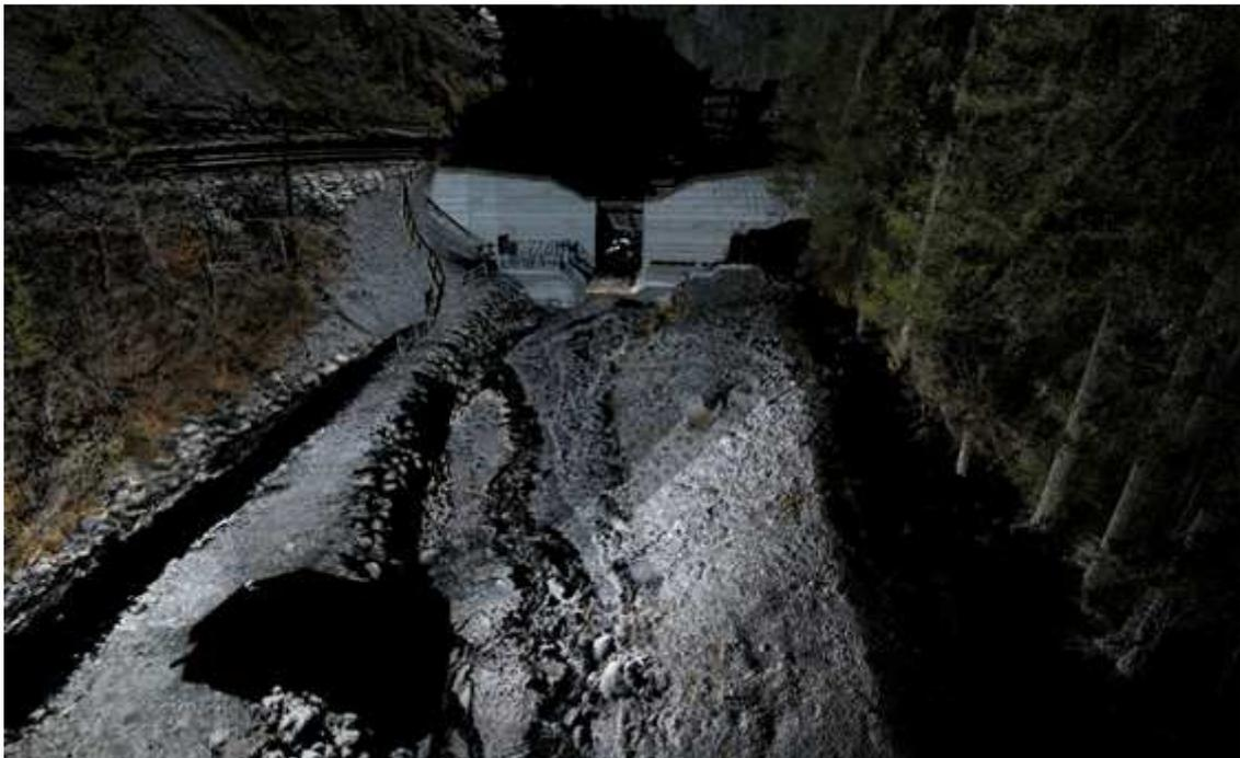
Abbildung 15: In RGB-Farben eingefärbte Punktwolke von der Sperre in Schlitzbauweise - die schwarzen Stellen sind Scanschatten, also Bereiche, die von dem ausgesandten Laserstrahl wegen Verdeckung nicht erreicht werden können. (Prokop, et al., 2011)
