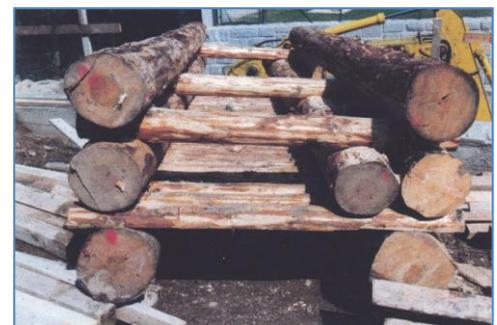
Foto 22: Schaffung eines Fischunterstandes durch Versatz des luftseitigen Baumstammes und seitlicher Begrenzung mit Füllhölzern (rechte Seite des Fotos) (Quelle: MERWALD, 1994)
