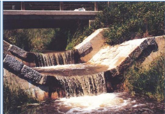
Foto 24: Die Kaskadenschwelle in Beton/Zementmörtelmauerwerksausführung (Quelle: MERWALD, 1994)
