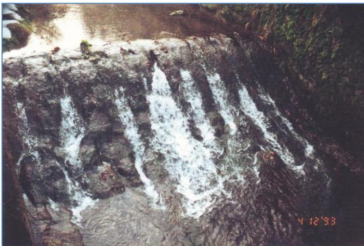
Foto 21: Sinoidalschwelle mit rauher Oberflächengestaltung (Quelle: MERWALD, 1994)
