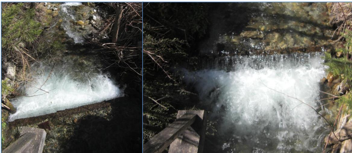
Foto 29: Holzsohlschwellen ohne Niederwasserrinne bei einer Brücke. Bei Niederwasser kann die Wasserführung nicht ausreichen, um eine Wanderung zu ermöglichen (eigene Quelle).
