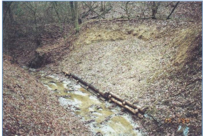
Foto 11: Einwandiges Holzleitwerk in Kombination mit Vegetationsbau (MERWALD, 1994)
