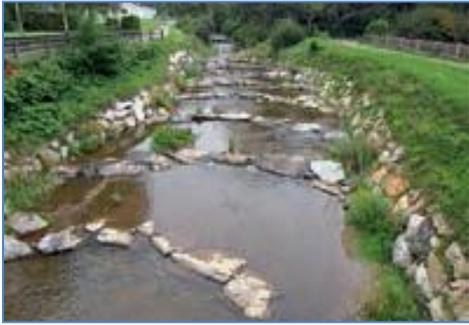
Foto 16: Pendelrampe mit pendelnder Niederwasserrinne durch wechselnde Anordnung der Beckenübergänge der einzelnen Schwellen (© ezb entnommen aus EBERSTALLER-FLEISCHANDERL & EBERSTALLER, 2014)
