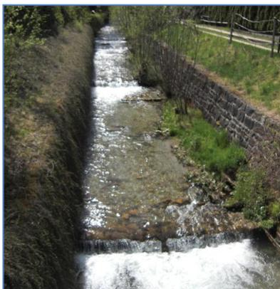
Foto 26: Abfolge niedriger Sohlschwellen mit ausgeprägten Kolken und Niederwasserrinnen (eigene Quelle)
