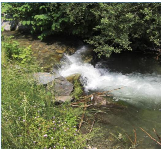
Foto 31: Doppelsonschwelle. Ein Aufstieg wird aufgrund der fehlenden Niederwasserrinne im oberen Bauwerksteil erheblich erschwert (eigene Quelle).
