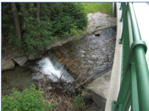
Foto 32: Sohlschwelle und darauf folgende Sohlpflasterung unter der Bundesstraßenbrücke (eigene Quelle).
