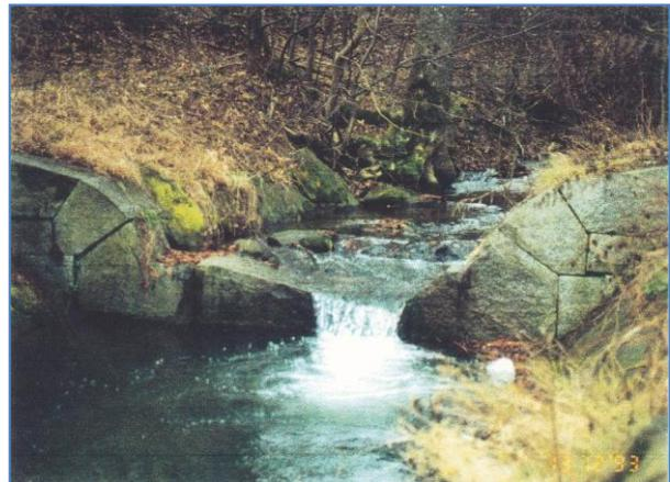
Foto 15: Grundschwelle mit schräger Abflusssektion und konzentriertem Abfluss (Quelle: MERWALD)
