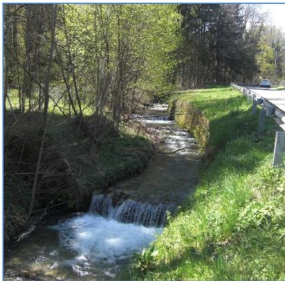
Foto 25: Sohlschwelle mit ausgeprägter Niederwasserrinne und tiefem Kolk (eigene Quelle)
