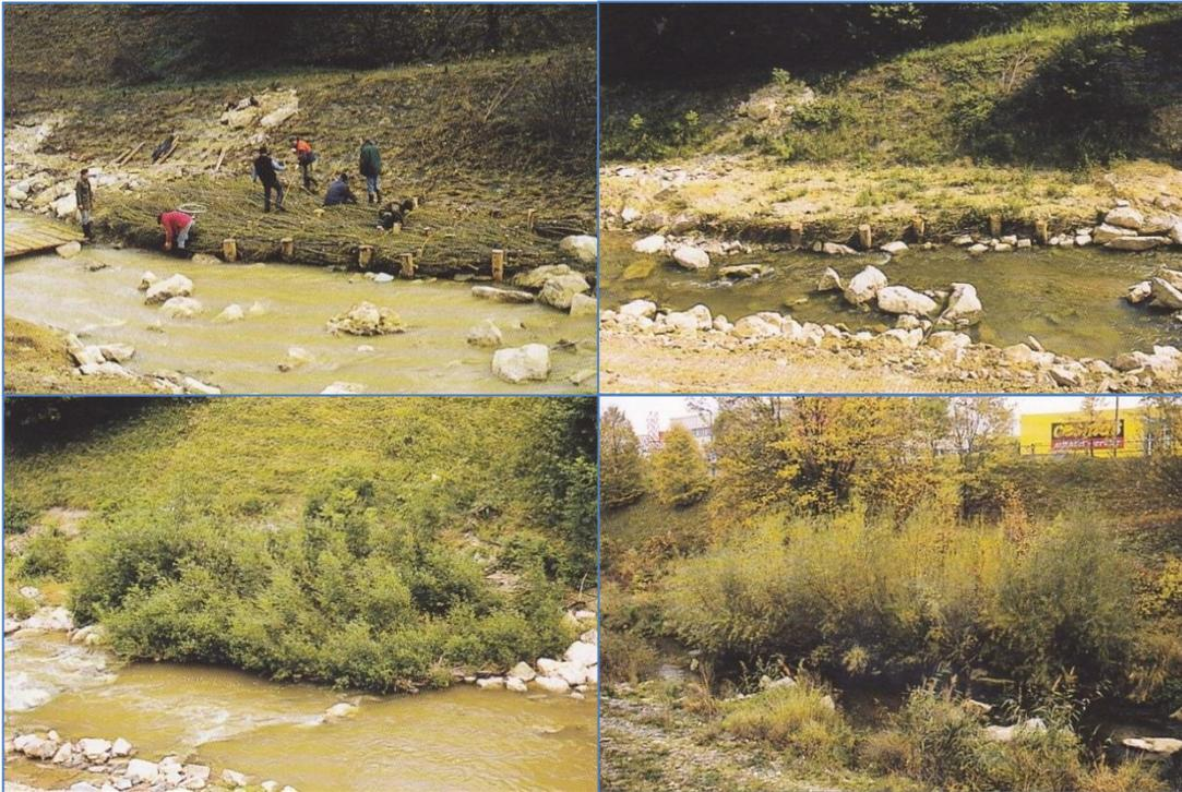
Foto 1: Einbau und zeitliche Entwicklung einer Astpackung über einen Zeitraum von drei Jahren (Quelle: FLORINETH, 2004)
