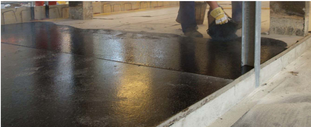
Abbildung 2: Beschichtung mit Gussasphalt in Ställen (HBLFA RAUMBERG-GUMPENSTEIN, 2008).
