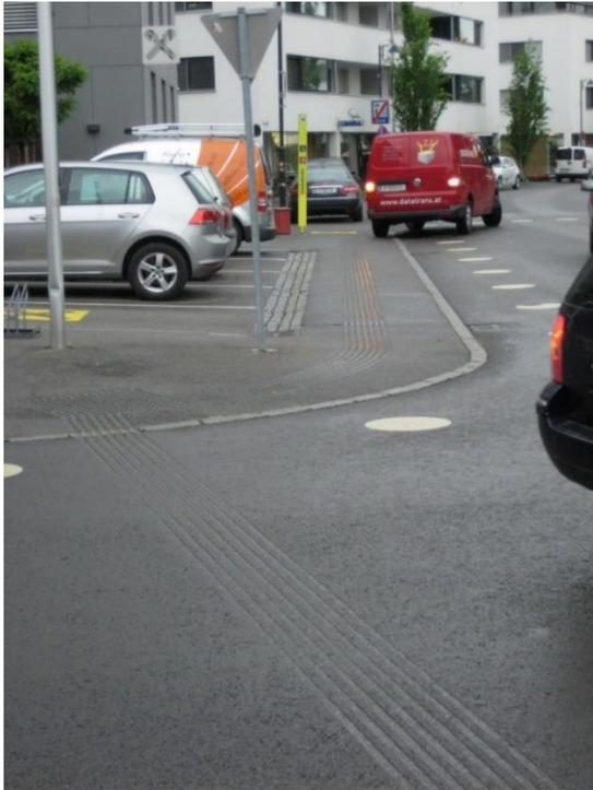
Abbildung 2.2-2: Taktiles Leitsystem, Hard
