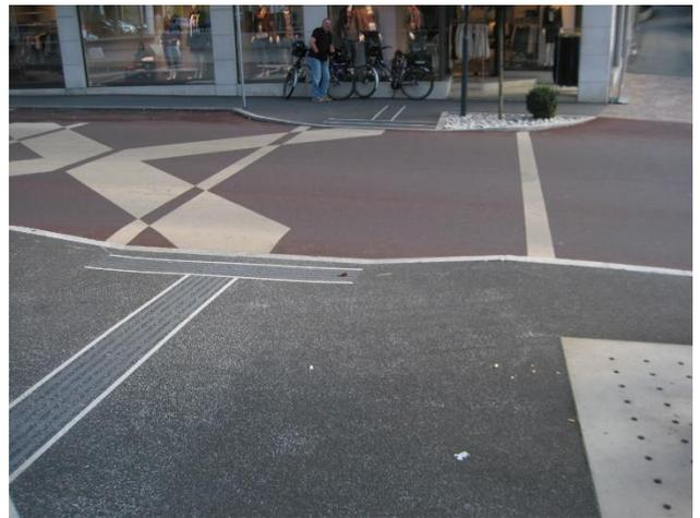
Abbildung 4.8-8: Taktiles Blindenleitsystem als Querungshilfe
