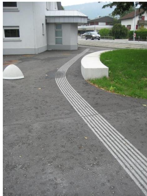
Abbildung 4.10-9: Taktiles Blindenleitsystem
