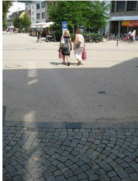
Abbildung 4.2-6: Taktiles Blindenleitsystem als Querungshilfe
