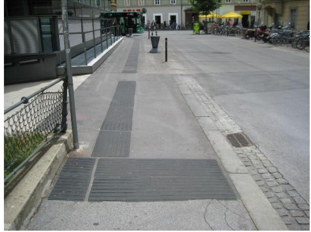
Abbildung 4.3-4: Taktiles Blindenleitsystem
