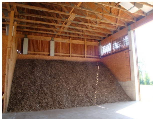
Abbildung 9: Trocknungsbox mit ganzflächigem Belüftungsboden, angefüllt mit Hackschnitzeln.
