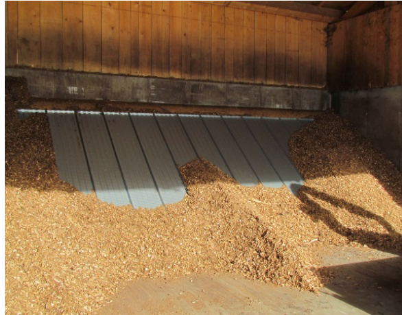
Abbildung 10: Kiemenartig perforierter Schrägrost, installiert in einer Trocknungsbox im natürlichen Schüttwinkel.
