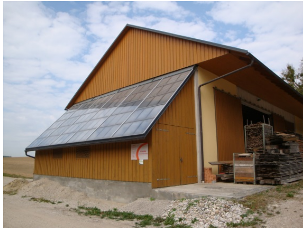
Abbildung 7: Dach mit integrierten und verglasten Solarluftkollektoren, im besten Falle nach Süden ausgerichtet.
