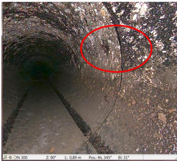
Abbildung 235: Beton DN300, Scan-System 2 3D, Riss, 2mm
