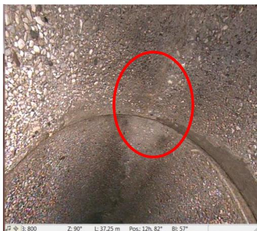
Abbildung 455: Beton DN500/800, Scan-System 2 3D, Riss, 1mm
