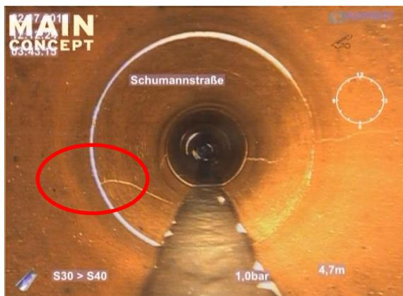
Abbildung 208: TV-Kamera 3, Riss, 2mm
