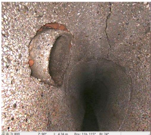
Abbildung 463: Zustandserkennung, Beton, DN 500/800, Scan-System 2, 3D, einragender Anschluss
