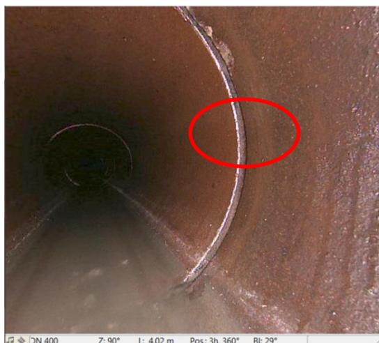
Abbildung 220: Scan-System 2 3D, Riss, Oberflächenriss
