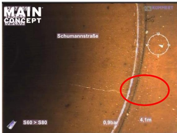
Abbildung 218: TV-Kamera 3, Riss, Oberflächenriss
