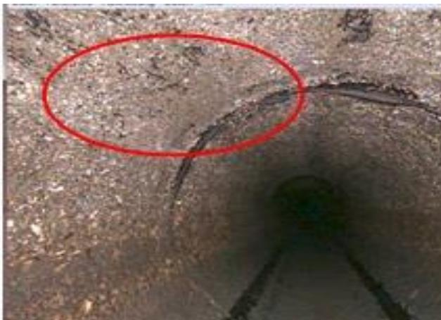
Abbildung 239: Beton DN300, Scan-System 2 3D, Bruch
