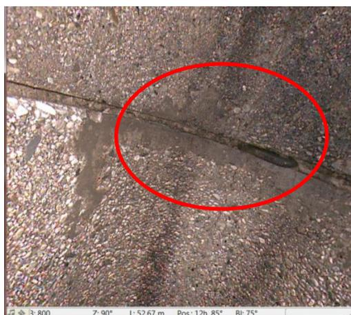
Abbildung 450: Beton DN500/800, Scan-System 2 3D, Riss, 2mm
