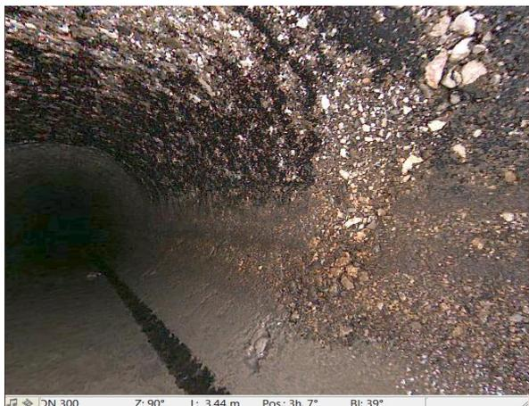
Abbildung 243: Beton DN300, Scan-System 2 3D, Oberflächenschaden (fehlende Zuschlagstoffe)
