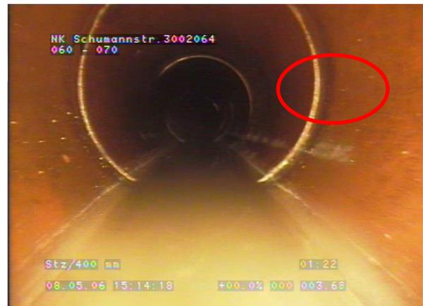
Abbildung 219: alte Befahrungen, Riss, Oberflächenriss
