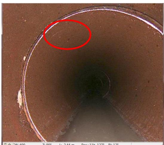
Abbildung 215: Scan-System 2 3D, Riss, 1mm
