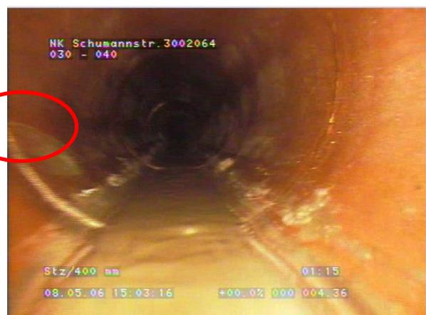
Abbildung 209: alte Befahrungen, Riss, 2mm
