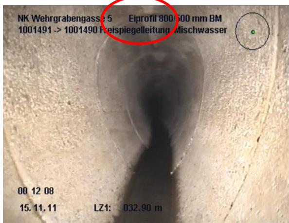
Abbildung 453: Beton DN500/800, alte Befahrungen, Riss, 1mm
