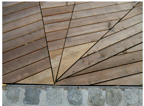
Abbildung 072: Strahlenförmig verlaufendes Fugenbild
