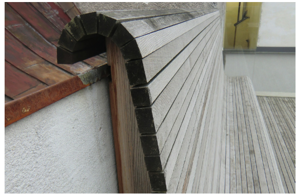
Abbildung 053: Maßangefertigte Deckleisten und Unterkonstruktion aus verleimten 3-Schichtplatten
