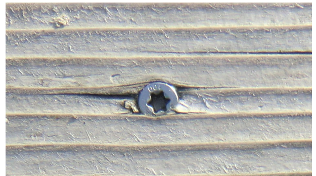
Abbildung 049: Ausrisse um den Schraubenkopf
