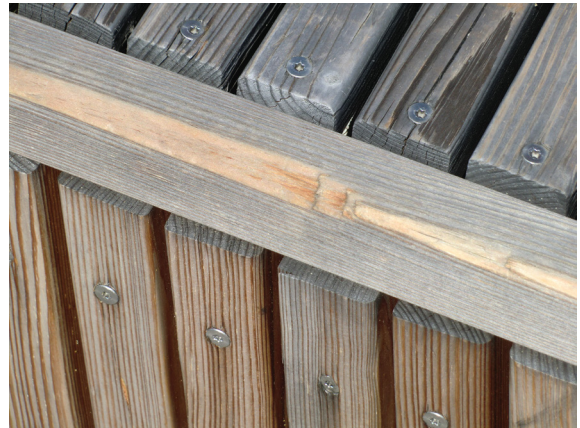
Abbildung 040: Ausbrechende Kanten
