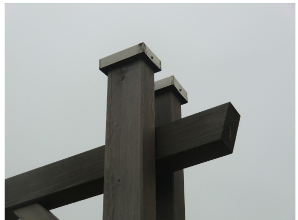
Abbildung 062: Schutz der Steher- und Pfettenstirnseiten
