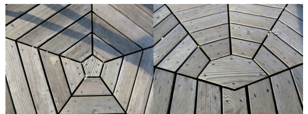
Abbildung 045: Sternförmige Verlegerichtung der Deckbretter
