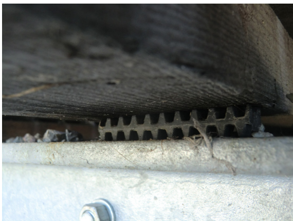
Abbildung 046: Abstandshalter zwischen Unterkonstruktion und Tragwerk
