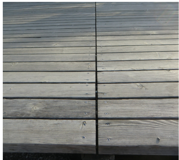
Abbildung 047: Fugenbild nach 3 Jahren intensiver Nutzung
