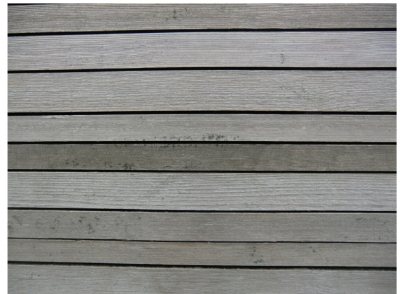
Abbildung 052: Unterschiedlich dicke Bretter und fehlende Fase der Decklage
