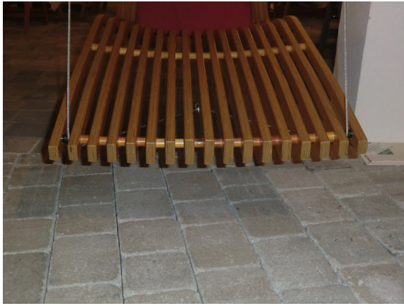
Abbildung 066: Rundhölzer als Abstandshalter mit innenliegenden Gewindestangen
