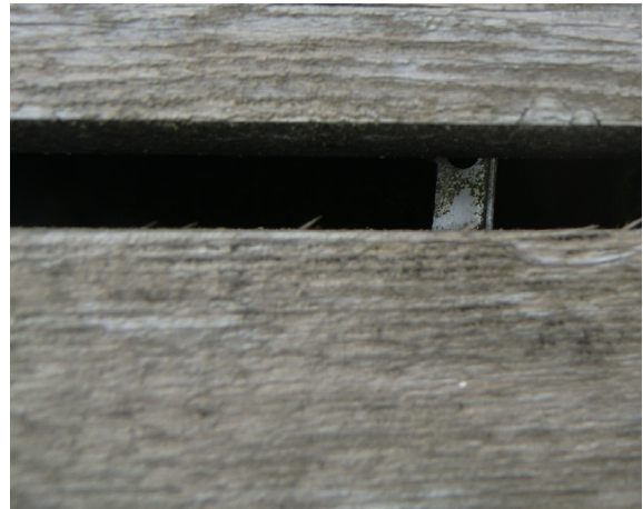
Abbildung 055: Algenf Im zwischen den Deckbrettern
