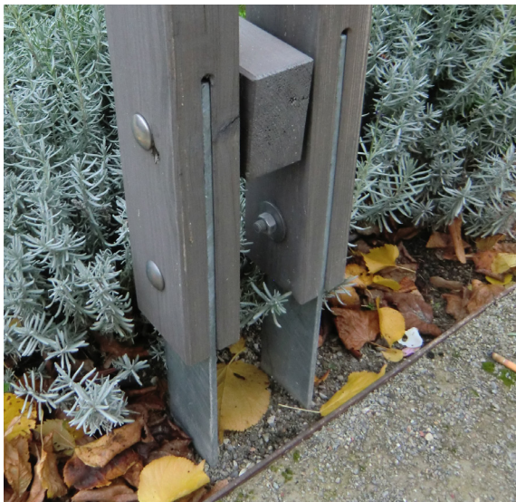
Abbildung 060: Einbetonierter Pfostenschuh
