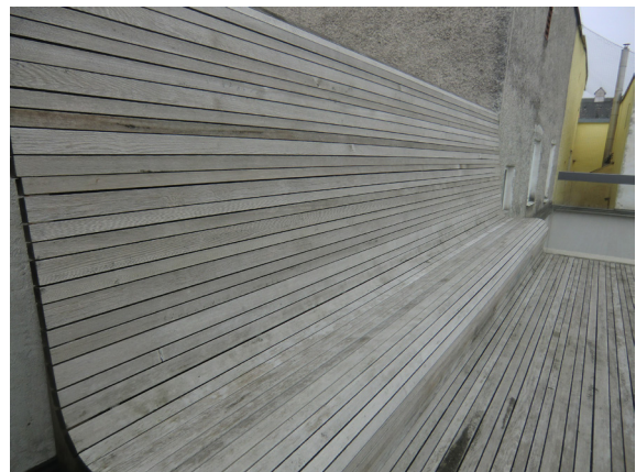
Abbildung 054: Nahtloser Übergang von Holzdeck zu Sitzbank
