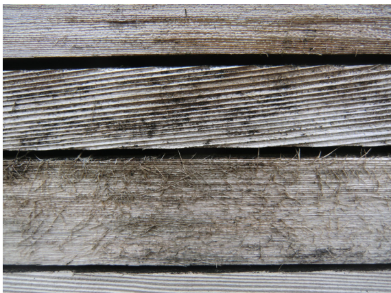
Abbildung 056: Verwitterungserscheinungen bei Western Red Cedar
