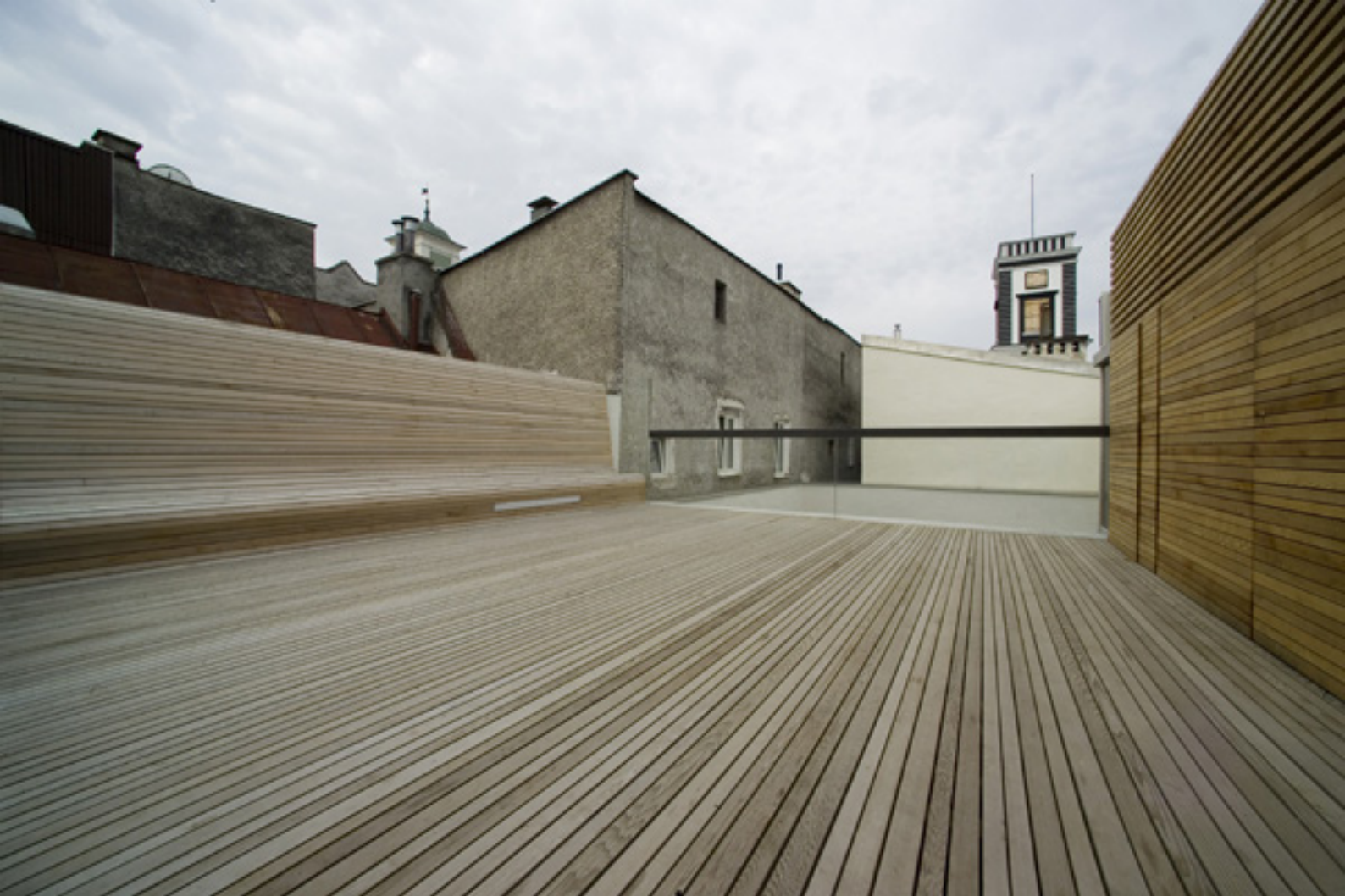
Abbildung 050: Die untere Dachterrasse kurz nach ihrer Fertigstellung 2006
