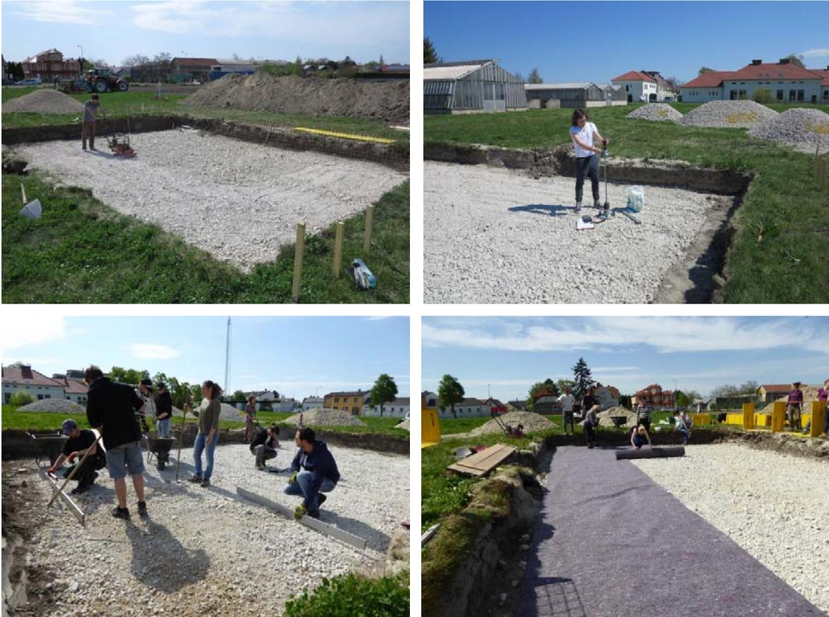
**Abbildung 12: Arbeitsschritte zur Herstellung der unteren Tragschicht der Versuchsfläche mit 25 cm 0/63 KK und 5 cm 0/32 KK und Ausbringung des Dränvlieses (Großenzersdorf, 27.-30.4.2015)**
