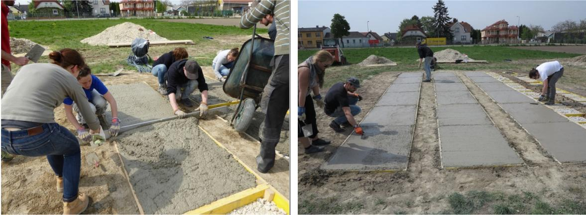
**Abbildung 19: Einbringung der Beton Deckschicht (Großenzersdorf, 27.-30.4.2015)**
