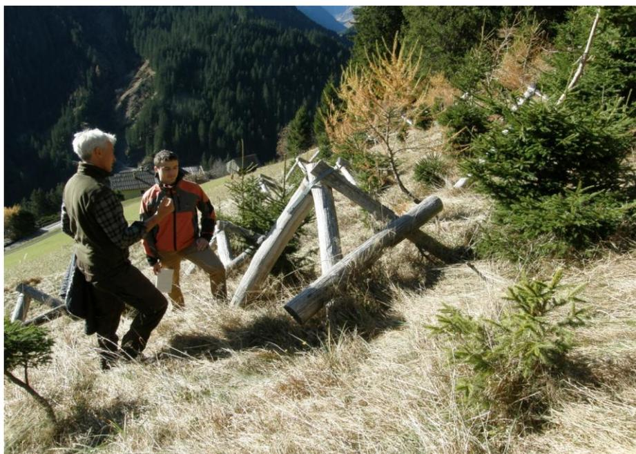
Bei der Errichtung werden Bündel zu je 8 Böcken zusammengestellt – dies entspricht ungefähr der Transportkapazität (750 – 850 kg) eines Hubschraubers Typ „Lama“, mit welchem die Böcke ins Gelände gebracht werden.
