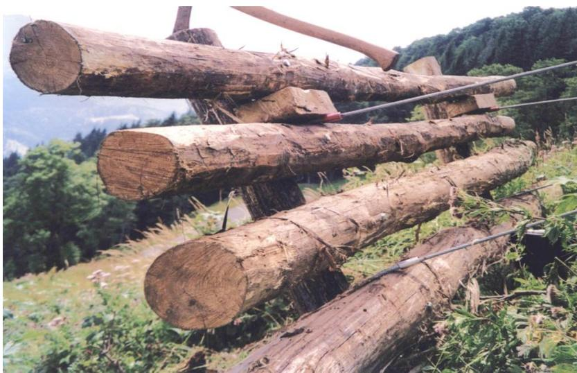
Abbildung 22: AGS - System mit vier Halteseilen, welche zu einem Hauptstrang führen.
