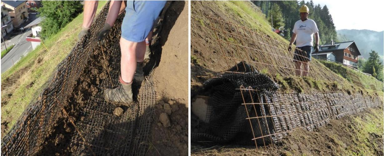
Abbildung 20: Links – Einsetzen des Geotextil und des Stahlbogens
