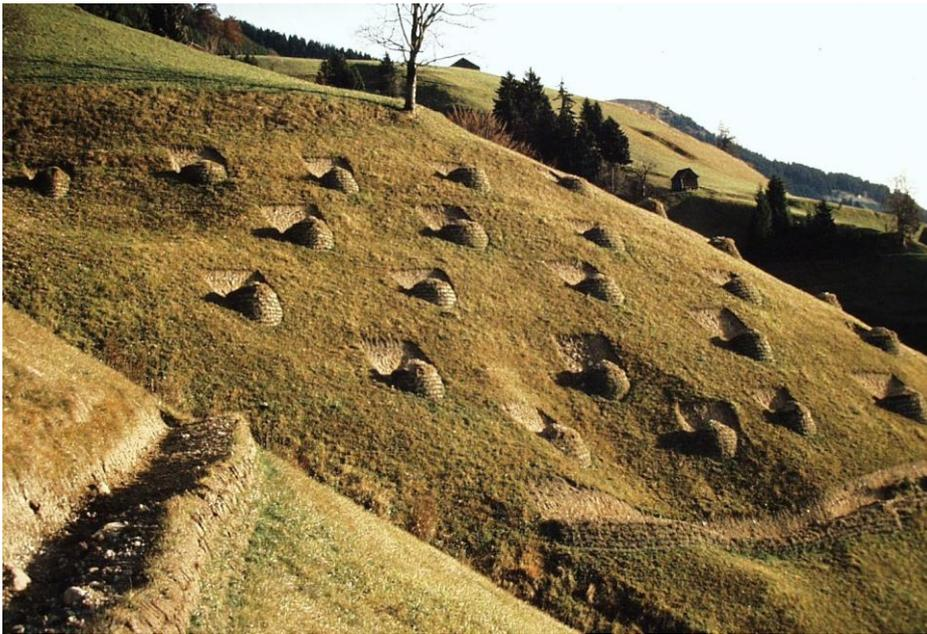
Diese Bauart wird, aufgrund der vielen nötigen Arbeitsstunden, nur mehr selten angewandt – was jedoch nicht deren Wirksamkeit mindern soll. Druckhügel sind eine wirksame Maßnahme gegen Gleitschnee. Die Errichtung ist jedoch mit Sorgfalt durchzuführen, sodass die Hügel der Belastung standhalten und die Erosionsgefahr minimiert wird. Zusätzlich bilden sich an den Druckhügeln sehr gute Mikrostandorte für unterschiedlichste Flora und Fauna.
