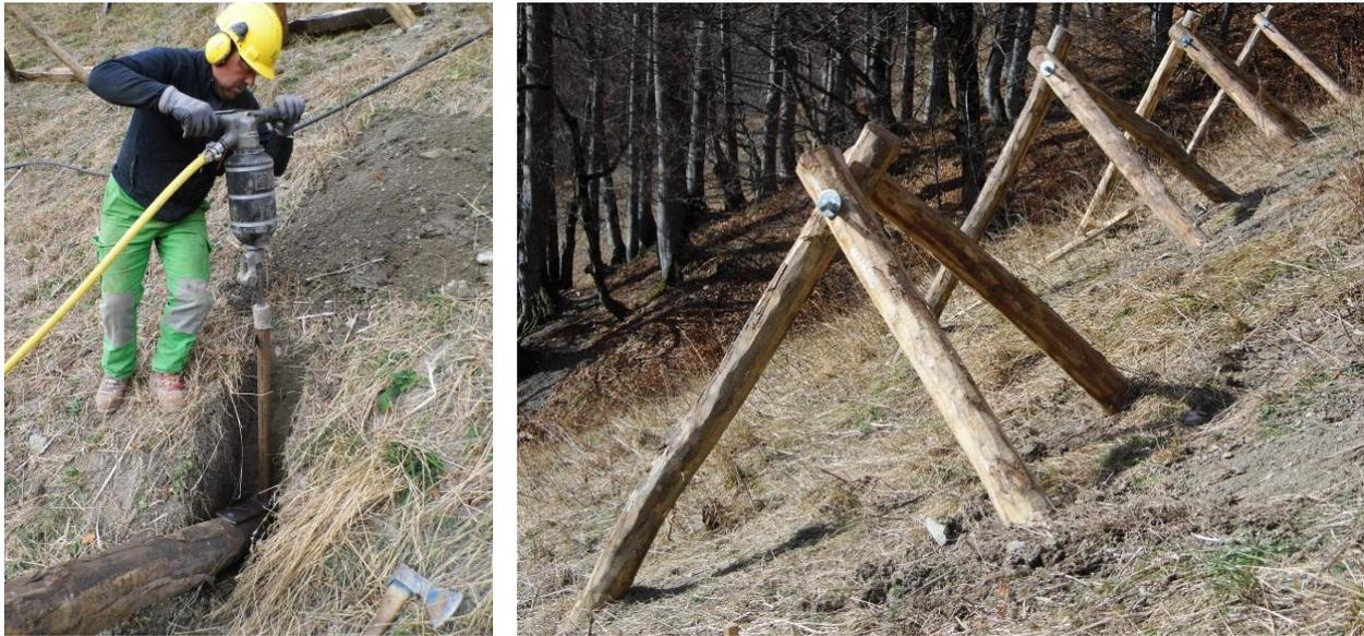
Abbildung 14: Links – Einschlagen des Ankers mittels Pressluft und Spezialaufsatz
