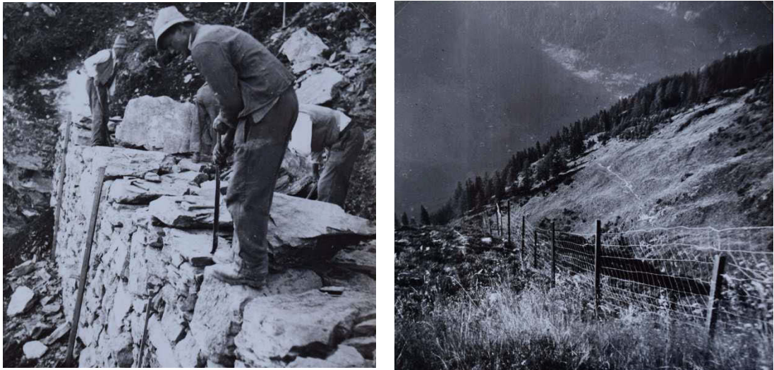
Abbildung 2: Links: Arbeiter bei der Errichtung einer Steinterrasse; Rechts: Kulturzaun (WLV, 1963)
