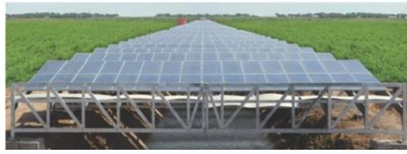
**ABBILDUNG 8** Vogelperspektive Solardach Abschnitt Narmada Canal (links) (Quelle: google.maps) und Narmada Canal mit 1 MW<sub>p</sub> Testkonstruktion (Quelle: Sahu u. a. 2016)
