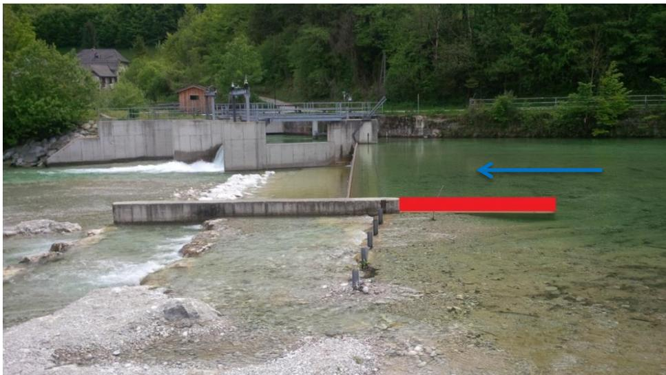
Abbildung 36: Bereich der Erhöhung des bestehenden Sporns für E4 (11.05.2016)
