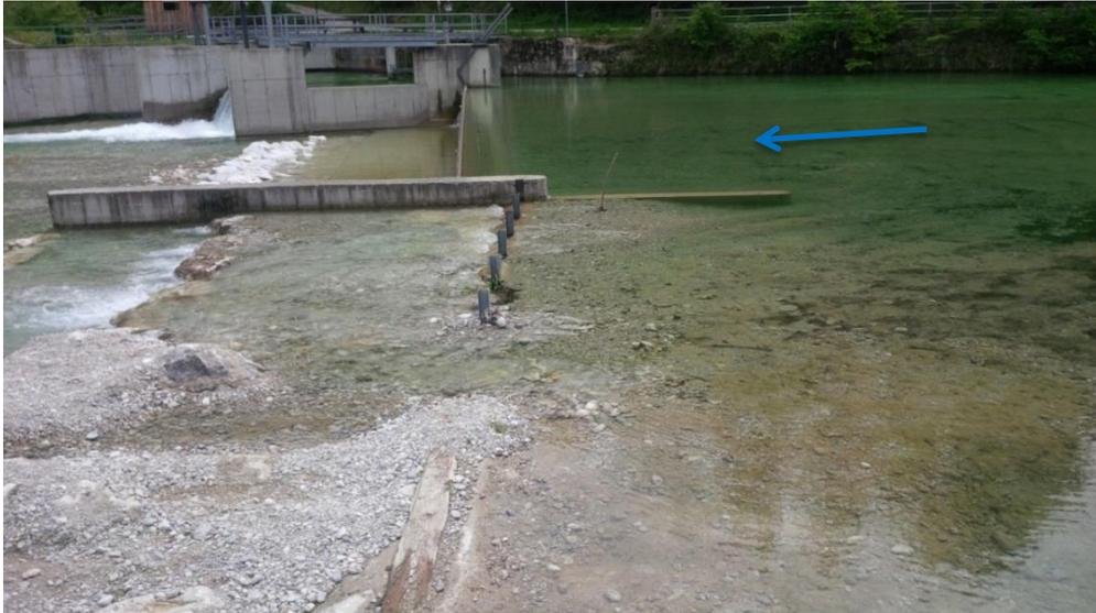
**Abbildung 11: Oberwasserbereich OWH - KW Gangljodl mit geringer Wassertiefe im Einlauf (11.05.2016)**
