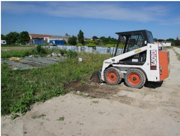
**Abbildung 22:** Abschälen der oberen Vegetationsschicht (12.07.2016)
