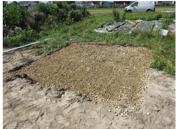
**Abbildung 23:** Herstellung der Drainageschicht (12.07.2016)
