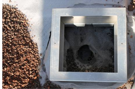
Abbildung 19: Aufbau der Vegetationstragschicht mit Kontrollschacht, Filtervlies und Intensivsubstrat, 06.05.2014 (EIGENE ERSTELLUNG).
