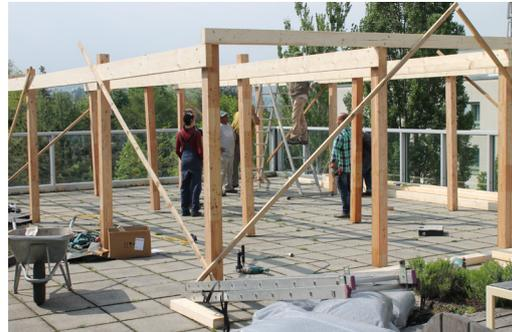
Abbildung 14: Unterkonstruktion der Pergola, 29.04.2014 (EIGENE ERSTELLUNG).
