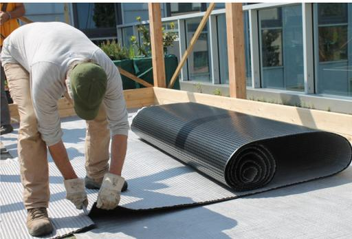
Abbildung 15: Einbau der Dränmatte, 30.04.2014 (EIGENE ERSTELLUNG).
