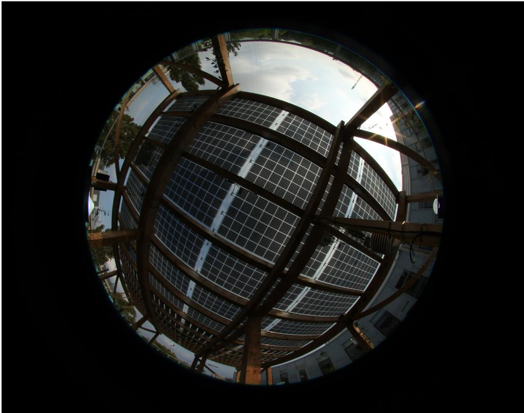
Abbildung 64: Aufnahme Spiegelreflexkamera mit Fischaugenobjektiv, zeigt einen Standort im Beet, dabei ist erkennbar, die Dachkonstruktion mit gelochten PV-Modulen 10.08.2014 (NACH WEIXELBAUMER LAUFENDE MASTERARBEIT).
