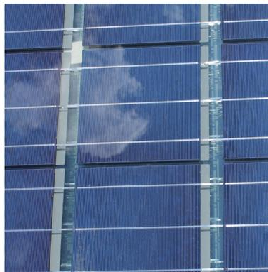
Abbildung 24: PV-Modul opake Zellen, 01.07.2014 (EIGENE ERSTELLUNG).
