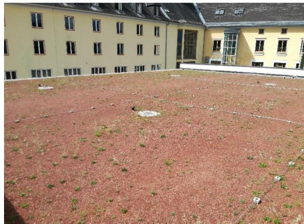
Abbildung 16: Dachbegrünung Internatsgebäude, Aufbau Drainageschicht Speicherplatte „Diadrain NP40“ (Quelle: EIGENE AUFNAHME, 2017)
