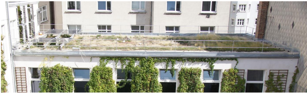
Abbildung 7 Schattenwurf auf dem Turnsaaldach des GRG7 durch das benachbarte Haus, von Zluwa I. (11.09.2018)
