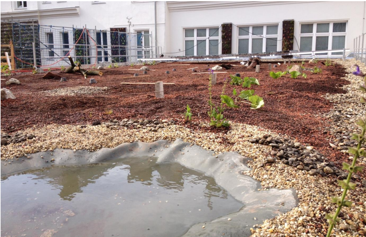
Abbildung 19 Aufbau und Verteilung der Strukturbildner am Dach des GRG7 (24.05.2016)
