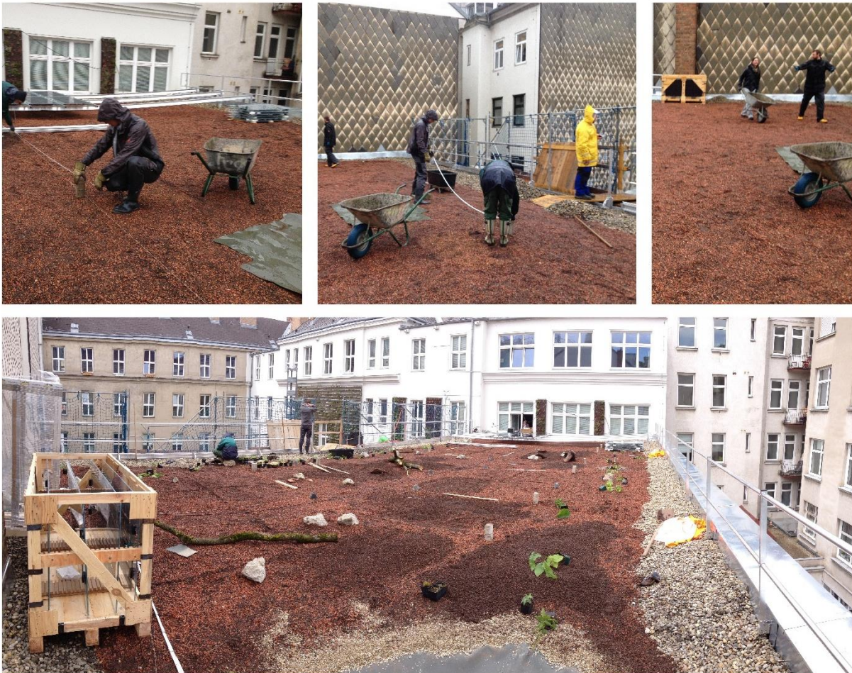
Abbildung 8 Aufbauarbeiten des Gründaches am GRG7, Wien von Zluwa I. (23.-24.05.2016)
