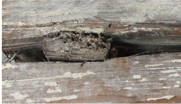
Abbildung 7: Ohne Vorbohrung eingeschlagener „flacher Keil“.
