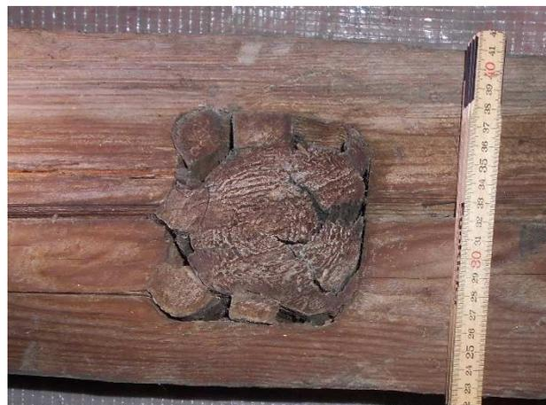
Abbildung 22: Querschnitt einer Rudersäule, gefunden im Heiligenkreuzerhof.
