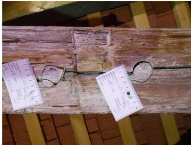
Abbildung 24: "Ausg'schermtes" Bauteil in einer Wiener Dachkonstruktion (Freyung 4).
