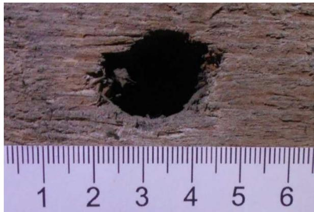
Abbildung 11: Mögliche Spur einer Floßschraube - gefunden in einer Wiener Dachkonstruktion (Freyung 2).
