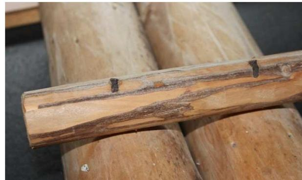
Abbildung 20: Befestigung mittels Floßnagel, Forstmuseum Großreifling.
