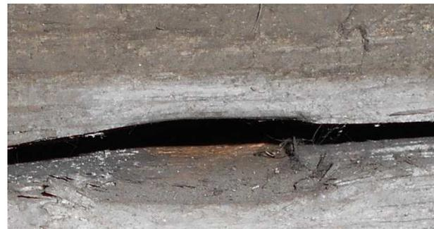
Abbildung 8: Spur eines entfernten „flachen Keils“.
