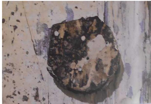
Abbildung 17: Runder Keil ohne Wiede. Gefunden in einer Wiener Dachkonstruktion (Fleischmarkt 9).
