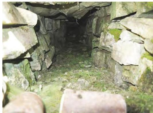
Abbildung 24: Trocken gemauerter Wasserauslass
