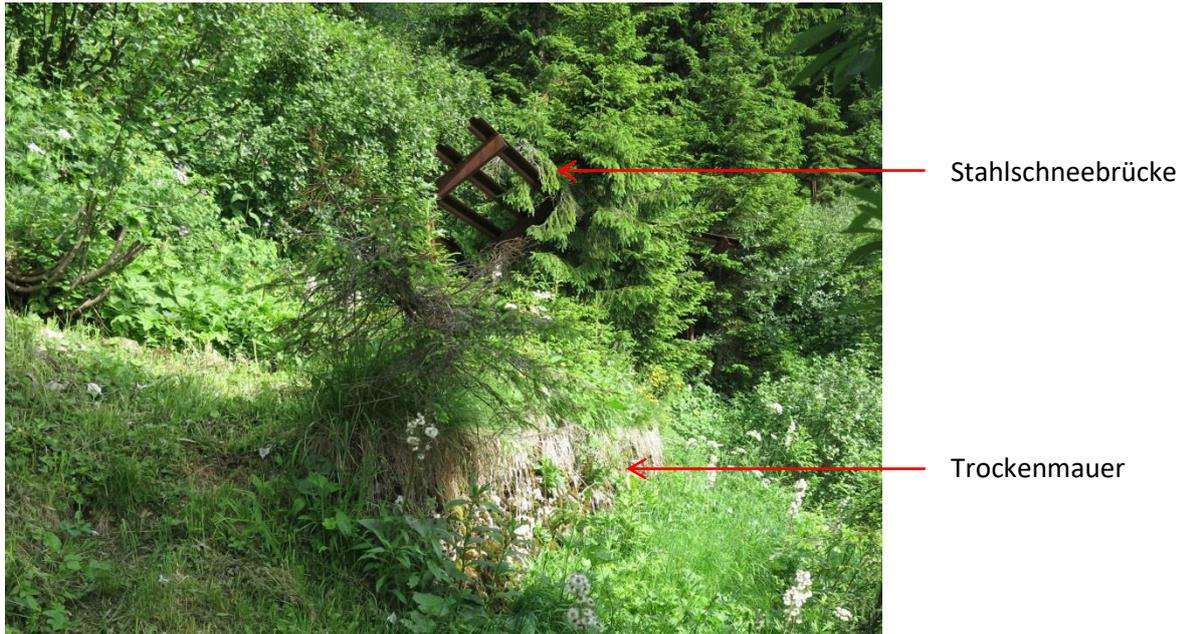
Abbildung 18: Eingewachsene Lawinenschutzbauten
