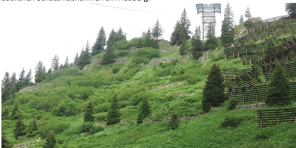
Abbildung 15: Übersicht Lawinenschutzverbauung unterhalb der Walmendingerhornbahn
