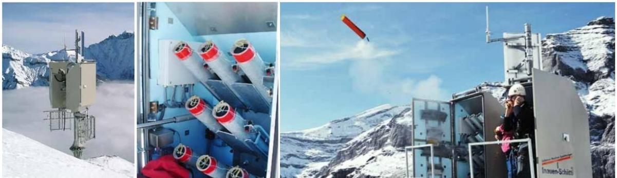
Abbildung 2.2: Der Lawinenwächter der Firma Inauen-Schätti. Im linken Bild der Mast mit zwei Schutzkästen. Im mittleren Bild sieht man die aufmagazinierten Abschussvorrichtungen bei geöffneter Tür des Schutzkastens. Im rechten Bild wird gerade eine Sprengladung ausgeworfen. (Inauen-Schätti, 2017).
