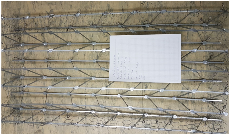
Abbildung 39: Vorbereitetes Gitter mit Hasennetz
