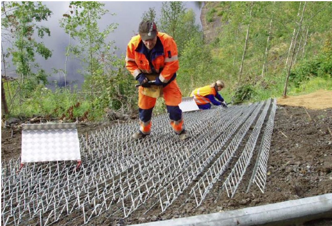
Abbildung 15: Schräger Einbau der Stahlgittermatten (DOCPLAYER, n.d.)
