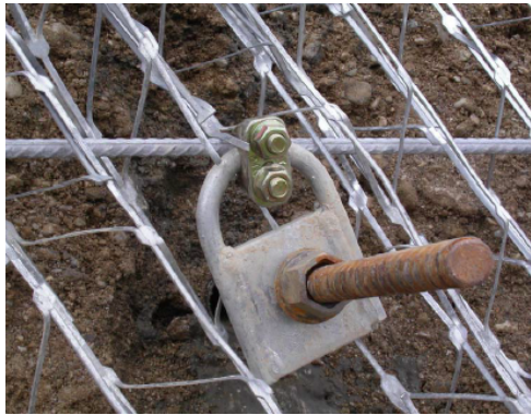
Abbildung 16: Verbindung von KRISMER Stahlgitternetz und GEWI – Bodennagel (SANIN, 2004)
