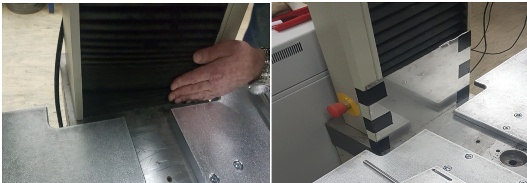
Abbildung 46: Installation eines Schutzbleches
