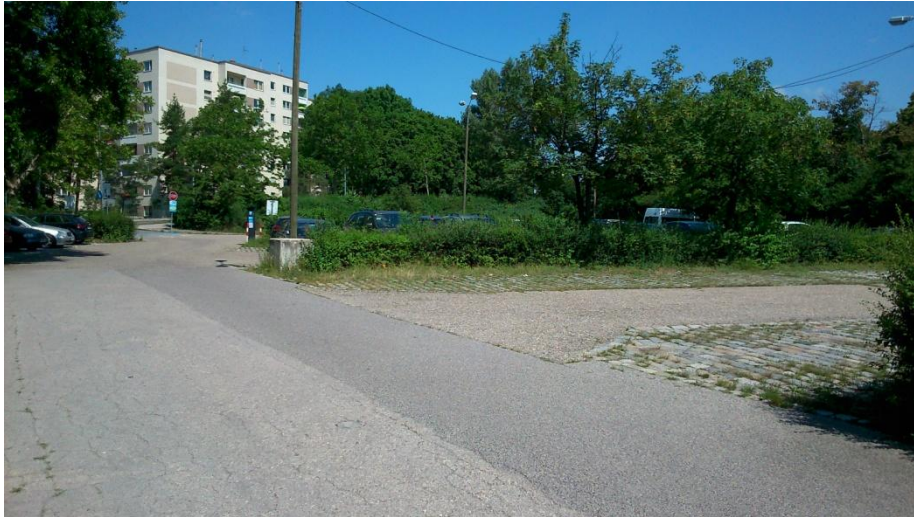
Abb. 2.2- 4: P+R Oberlaa, Blick Richtung Norden (2)
