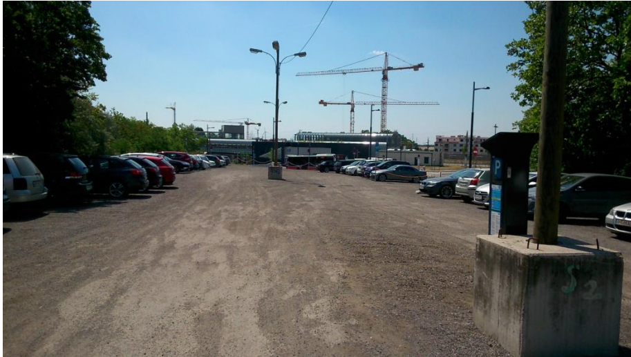
Abb. 2.2- 6: P+R Oberlaa, Blick Richtung Süden (2)
