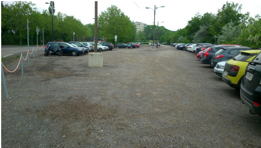
Abb. 2.2- 3: P+R Oberlaa, Blick Richtung Norden (1)
