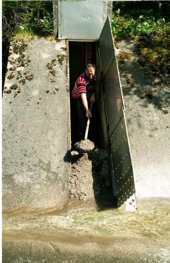
Abbildung 15: Instandsetzungsarbeiten am Messgerinne
