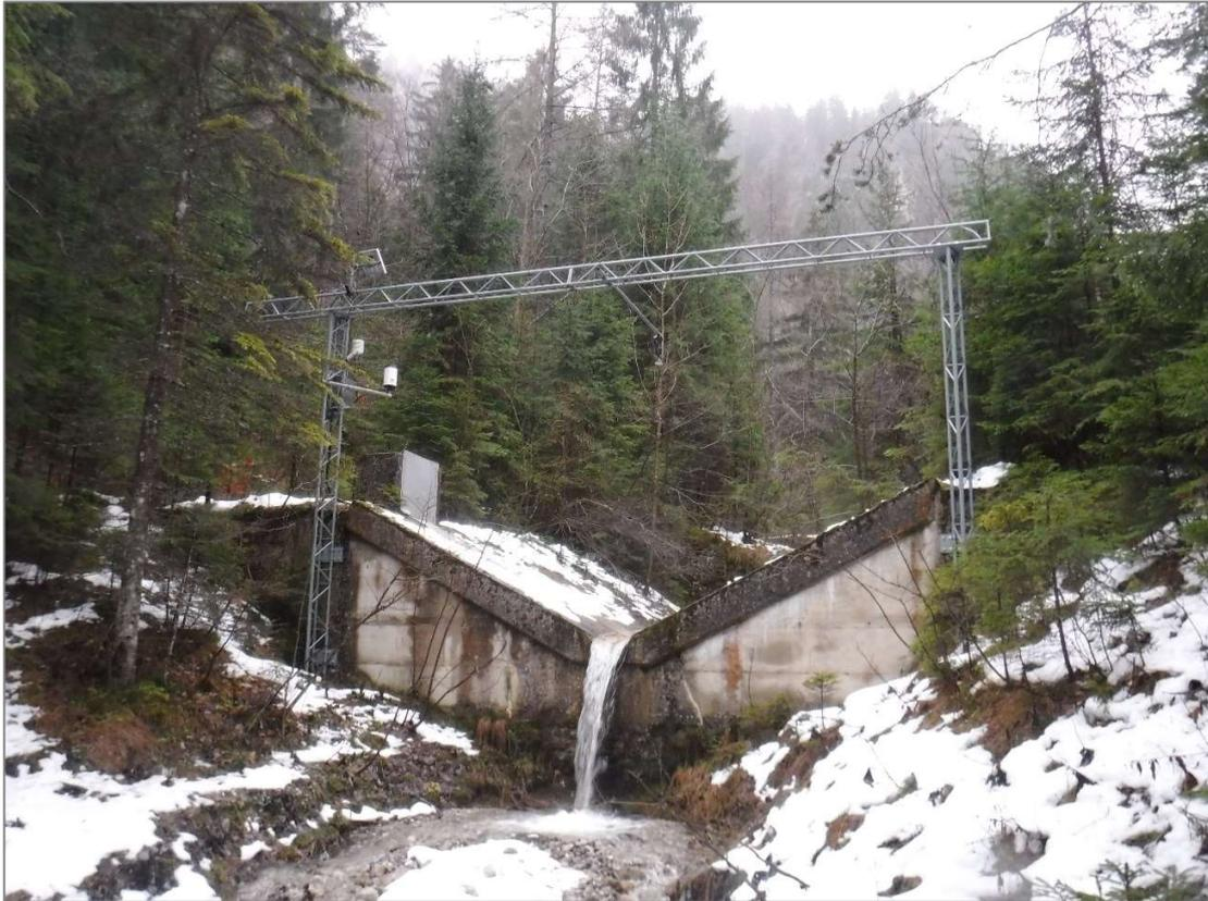
*Abbildung 16: Messgerinne mit Trägerkonstruktion für die Messgeräte bei der Begehung am 04.12.2018*
