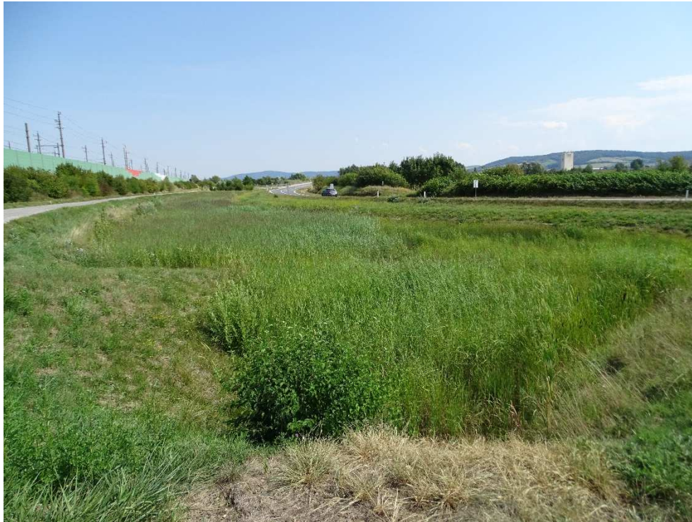
Abbildung 2: Regenrückhaltebecken in der Nähe des Bahnhofs Tullnerfeld (20. August 2018).
