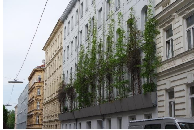
Abb. 20: Mischform Fassadenbegrünung, 1050 Wien (Quelle: eigene Erstellung 2015)
