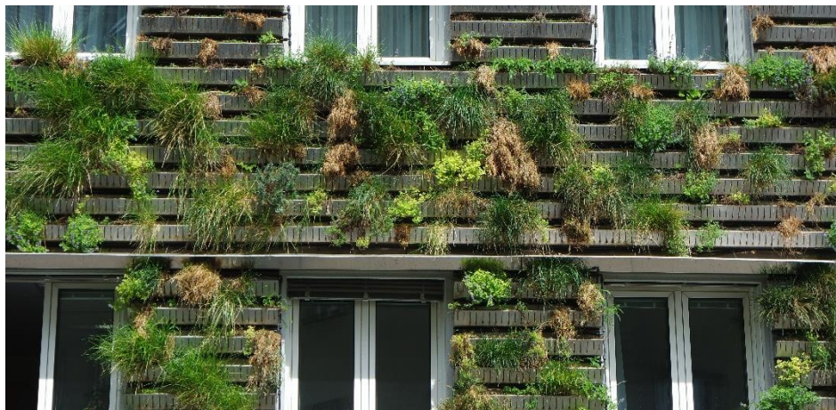
Abb. 21: Geschossweise Brandschutzschotts am Gebäude, 1050 Wien (Quelle: eigene Erstellung 2015)
