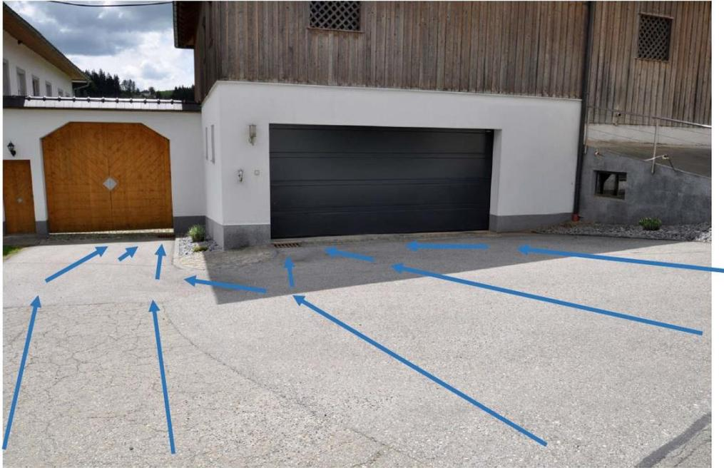
Abb. 5-3: Beispiel 2 für Schwierigkeiten bei der Bewertung von Entwässerungseinrichtungen, eig. Darst. Das nächste Beispiel zeigt eine öffentliche Verkehrsfläche am Rande einer Siedlung:
