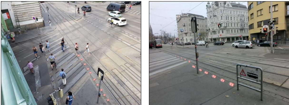
Abbildung 5.3-13: Anbringung von Lane Lights bei Schutzweg und Gehsteigkante an südwestlicher Ecke der Kreuzung
