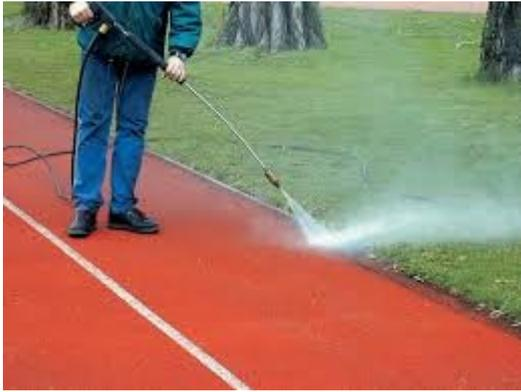
**Abbildung 3: Randreinigung mit Hochdruckgerät**
