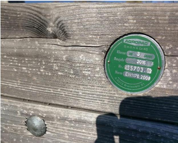
Abbildung 67: Das Siegel des Herstellers "Agropac" auf einem Gerät in St. Corona am Wechsel. In die Metallplakette eingestanzt sind empfohlenes Mindestalter für die Benutzung, das Baujahr, eine (vermutliche) Seriennummer und die Euronorm für die Herstellung von Spielgeräten.
